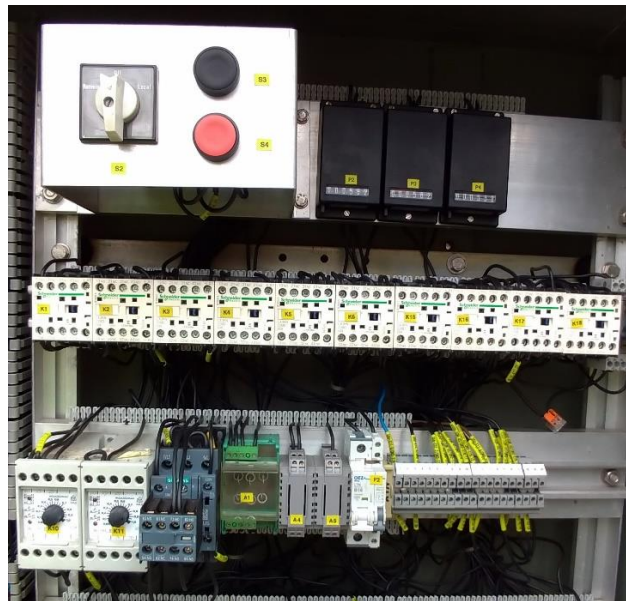
Obr. 9.4 Ovládací skrinu vypínača S1-245.
