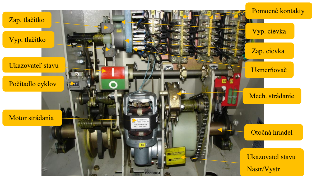
Obr. 4.2 Detail mechaniky vypínača VD4.
