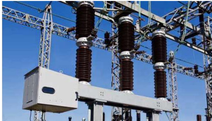
Obr. 3.4 Vypínač 3AV1FG 72.5 kV od spoločnosti Siemens [4].
