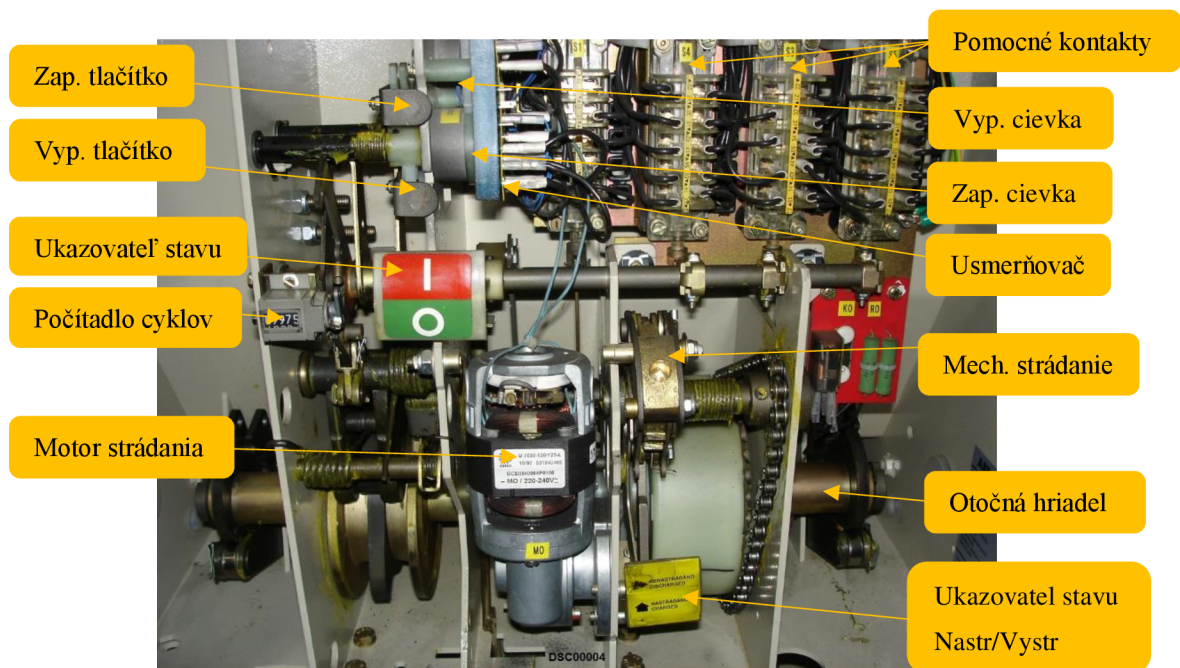
Obr. 4.2 Detail mechaniky vypínača VD4.
