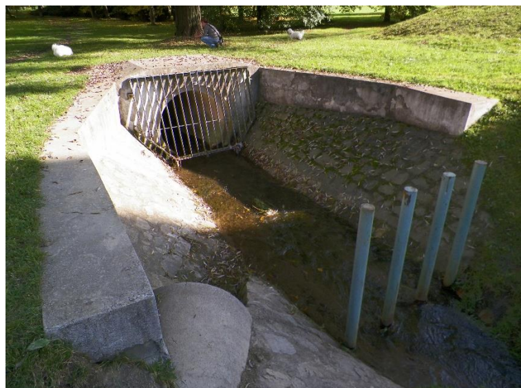
Obrázek 17 Betonové ústí Koželužského potoka
