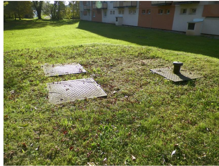
Obrázek 18 Kanalizační šachty v blízkosti ústí potoka
