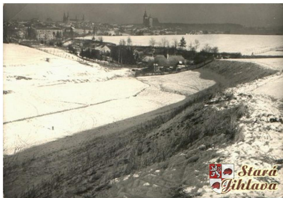
Obrázek 8 Pohled na východní část Skalky, rok neuveden
