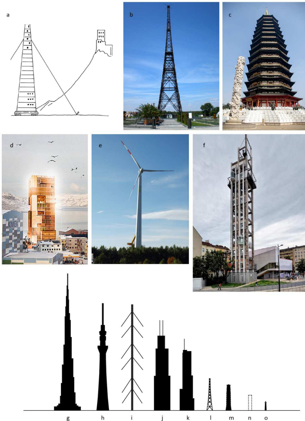
Obr. 01: a) Diadova dobývací věž(dřevo, 50m) b) vysílač v Glivicích (dřevo, 98m) c) pagoda v čínském Tianingu (dřevo, 153m) d) návrh kulturního centra v norském Kirkenes (17 podlaží) e) dřív větrné elektrárny Timber Tower (dřevo, 100m) f) vyhlídková věž Bahnorama ve Vídni(dřevo, 66m) g) nejvyšší stavba světa dubajský mrakodrap Burj Khalifa (kombinovaná konstrukce železobeton a ocel, 828m) h) nejvyšší samostatně stojící věž - tokijská Sky Tree (kombinovaná konstrukce železobeton a ocel, 634m) i) nejvyšší kotvená konstrukce – vysílač v Severní Dakotě (ocel, 628m) j) nejvyšší čistě ocelový mrakodrap – chicagský Sears Tower (ocel, anténa 527m, střecha 442m) k) nejvyšší železobetonový mrakodrap chicagský Trump Tower (železobeton, špice 423m, střecha 356,9m) l) nejvyšší postavená dřevěná konstrukce – vysílač Mühlacker (dřevo, 190m, zbořen nacisty v roce 1945) m) nejvyšší stojící dřevěná konstrukce – pagoda v Tieninu (dřevo, 153m), n) nejvyšší navrhovaný obytný dům – prefabrikovaný systém Tall Wood (dřevo, 30 podlaží), o) nejvyšší trvalá vyhlídková věž v Evropě Bohdanka (dřevo, 52,2m).
