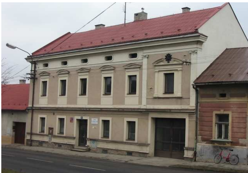
3. snímek: Budova objektu stavebního dvora, Dřevohostice, Dolní 107 (Fotoarchív ústavu)
