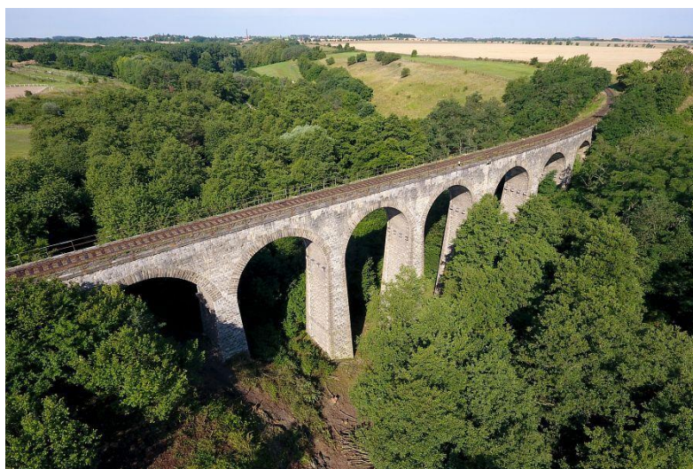
Obrázek č. 2 – Železniční viadukt přes Polepské údolí (autor: Roman Šulc, ©2019)
