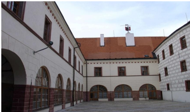
Obr. č. 30 – první nádvoří nového zámku se zasklenými arkádami
