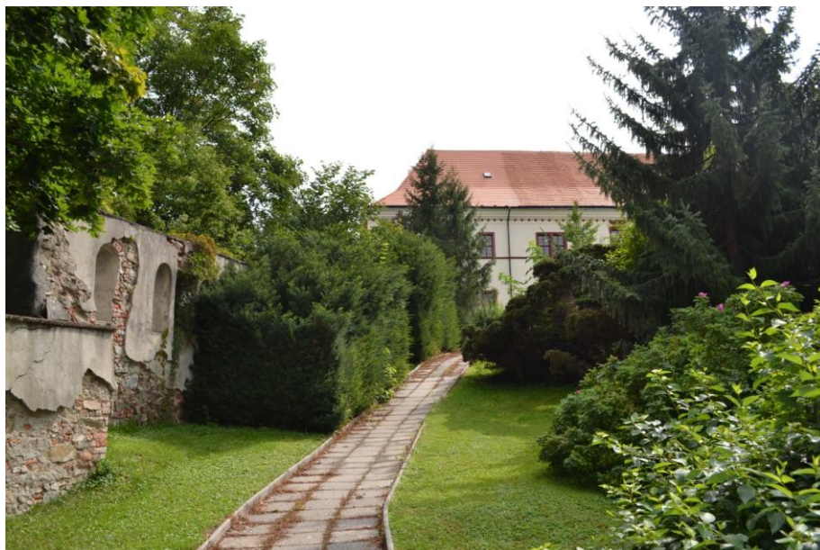
Foto č. 6 – chodník vedoucí kolem celého parku. Je tvořený betonovými kostkami. Je zde vidět, jak je hradní zeď v devastovaném stavu, bylo by vhodné, aby se alespoň nově omítila. Dřeviny lemující chodník z pravé strany jsou neudržované a ve stádiu rozkladu, výjimku tvoří vzrostlé exempláře Picea pungens . Z levé strany je lemován stříhanou stěnou z Taxus baccata .
