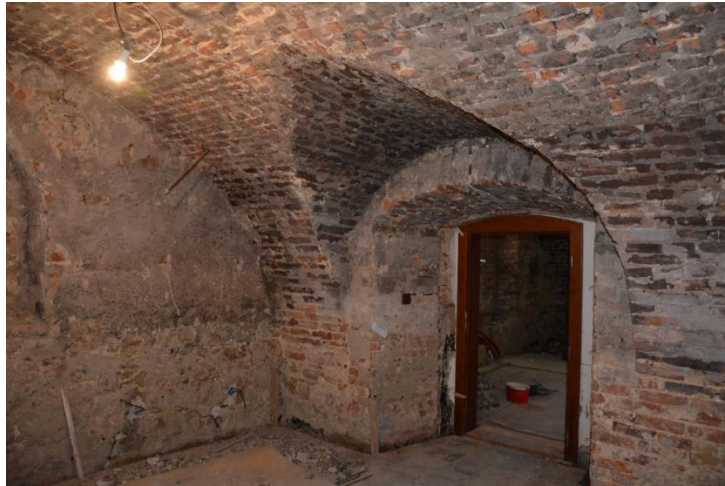
Obr. 45 Cihlová klenba sklepa zámku ve Staré Vsi nad Ondřejnicí se zbytky renesanční omítky
