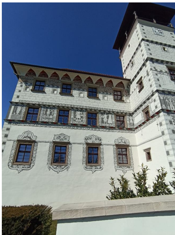
Obr. 48 Levá část hlavního průčelí zámku ve Staré Vsi nad Ondřejnicí, detail
