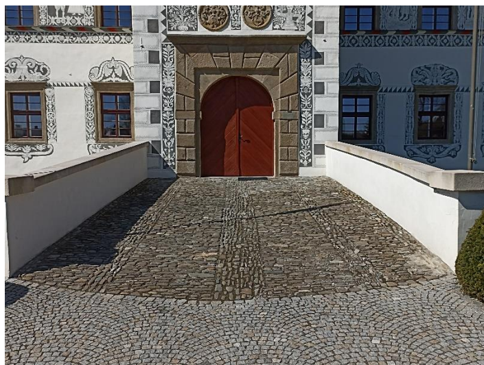
Obr. 22 Vstupním portál zámku ve Staré Vsi nad Ondřejnicí s mostem
