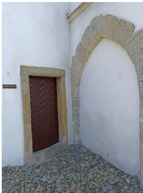
Obr. 66 Schodiště věže kostela sv. Jana Křtitele ve Staré Vsi nad Ondřejnicí točitého charakteru a přízemí kostelní věže se vstupem na točité schodiště
