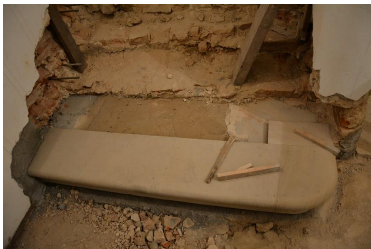
Obr. 38 Renesanční pískovcové schodiště ukryté pod betonovými schodišťovými stupni
