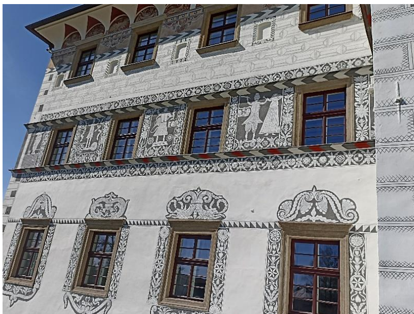
Obr. 47 Levá část hlavního průčelí zámku ve Staré Vsi nad Ondřejnicí, detail
