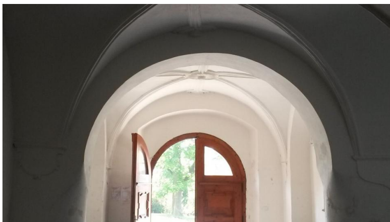
Obr. 52 Interiéry přízemních místností s valenou křížovou hřebínkovou klenbou, místy se štukovými žebry v zámku ve Staré Vsi nad Ondřejnicí
