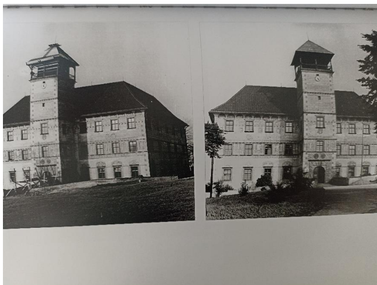
Obr. 36 Průčelí zámku ve Staré Vsi nad Ondřejnicí z roku 1965 s restaurovaným sgrafitem na fasádách a s novým krovem, druhý snímek zachycuje zámek v roce 1972
