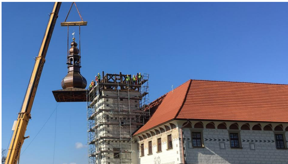
Obr. 107 Nová cibule je replikou, která byla vytvořena podle dobových fotografií. V makovici je umístěno sdělení pro další generace
