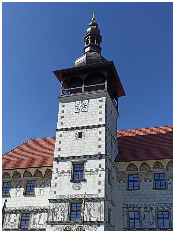
Obr. 41 Zámek s čtvercovým půdorysem, s vnitřním malým nádvořím zdobeným otevřenými arkádami a představenou věží
