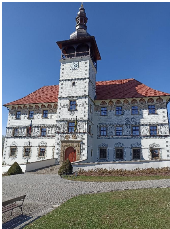
Obr. 20 Hlavní jihovýchodní průčelí zámku ve Staré Vsi nad Ondřejnicí
