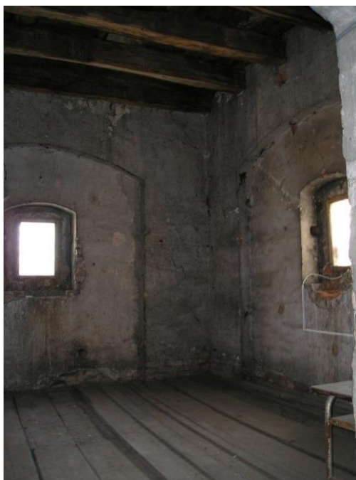
Obr. 42 Třetí parto zámku ve Staré Vsi nad Ondřejnicí před rekonstrukcí 2008
