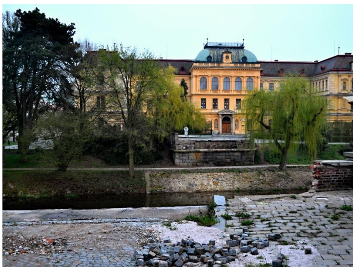
Obrázek 17. Pohled přes Labe v ulici Komenského v Jaroměři v roce 2013 poté, co zde povodeň strhla most. Zdroj obrázku: Archiv autora
