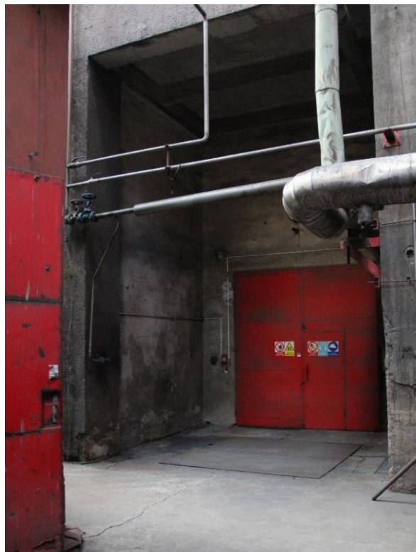
Obr. 34 Vstup do budovy kotelny.
