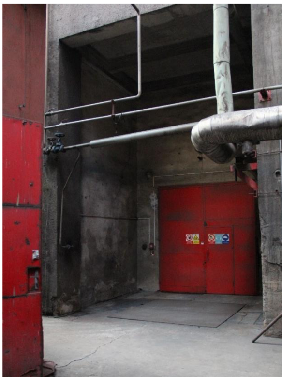
Obr. 34 Vstup do budovy kotelny.
