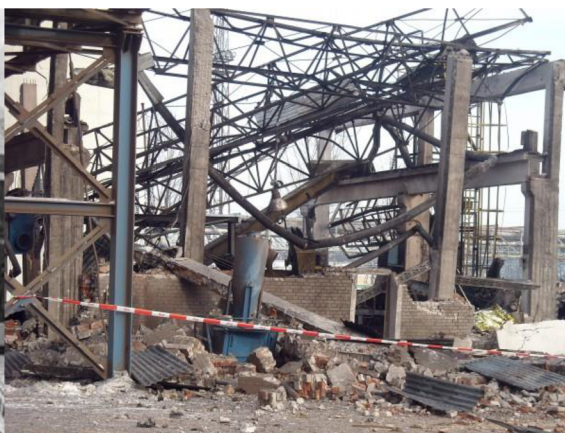
Obr. 19 Výbuch v elektrárně Dolna Odra. [11]
