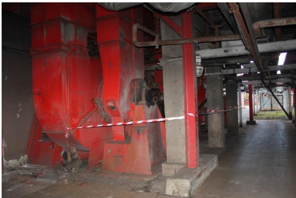
Obr. 31 Pozice stávajícího vzduchového ventilátoru kotle K4 – místo pro nový ventilátor
