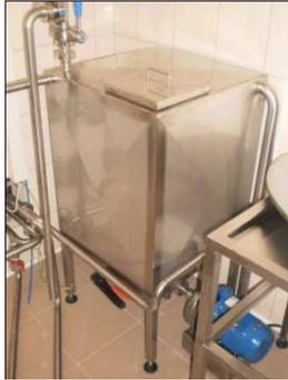
Un autre réservoir important dans la salle de production est destiné au lavage du réseau des tuyaux ainsi que du pasteur ou bien bassine de fabrication.
