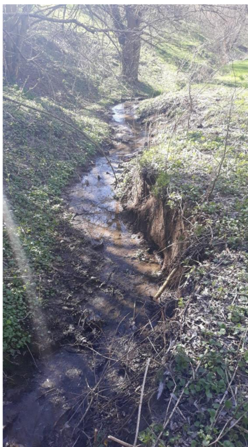
Obrázek 23- probíhající stranová eroze, tok č. 12 – bezejmenný Klokočí
