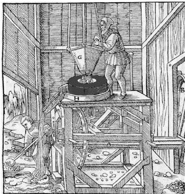
Obrázek 19: Mletí rudy podle Agricoly
