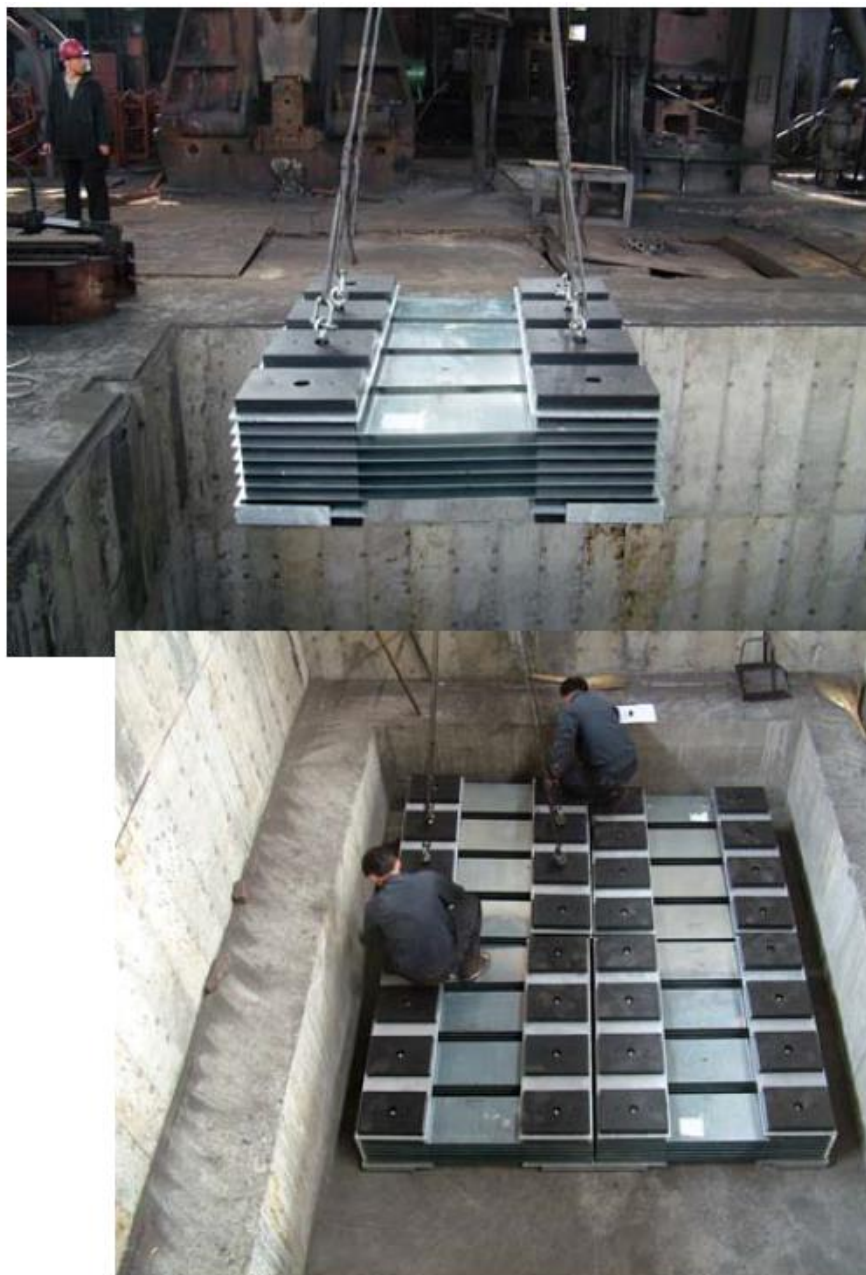
Obr. 9 Inštalácia elastomérových vrstvených izolátorov pre buchar s 10t baranom, firma Vibrodynamics [5]
