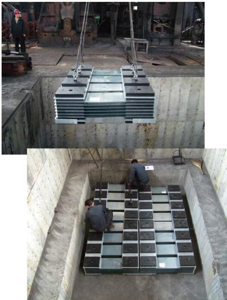
Obr. 9 Inštalácia elastomérových vrstvených izolátorov pre buchar s 10t baranom, firma Vibrodynamics [5]
