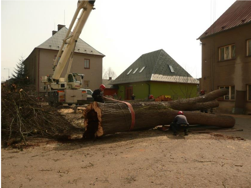
Obr. 56: kácení s pomocí jeřábu je vhodné i u silně vyhnílych stromů
