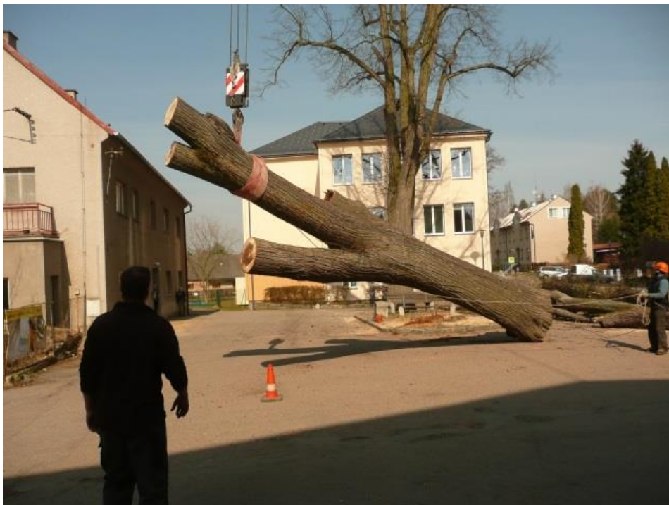
Obr. 55: spouštění kmene jeřábem na volnou vyhraněnou plochu
