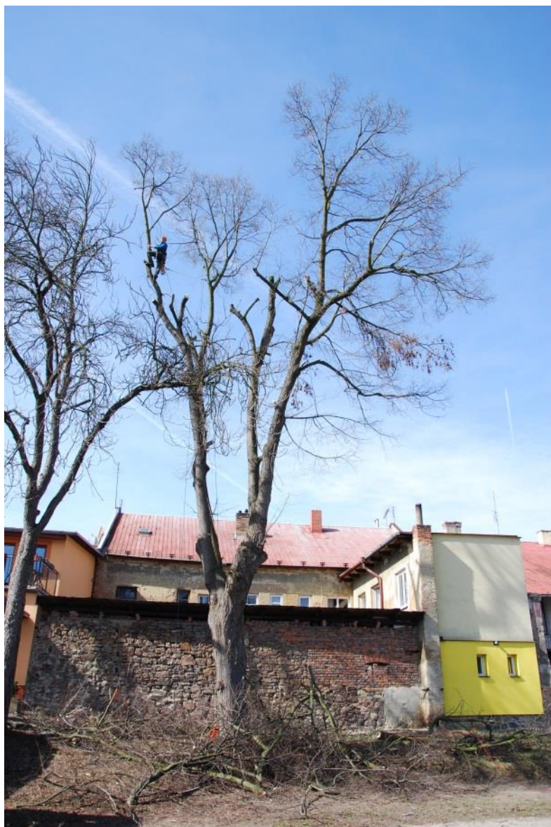
Obr. 35: při postupném kácení listnatých stromů arborista při odstraňování větví postupuje od menších větví k těm větším
