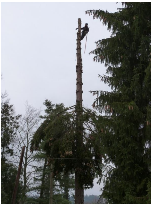
Obr. 46: spouštění špice stromu, která by mohla poškodit elektrické vedení nebo na druhé straně rodinný dům
