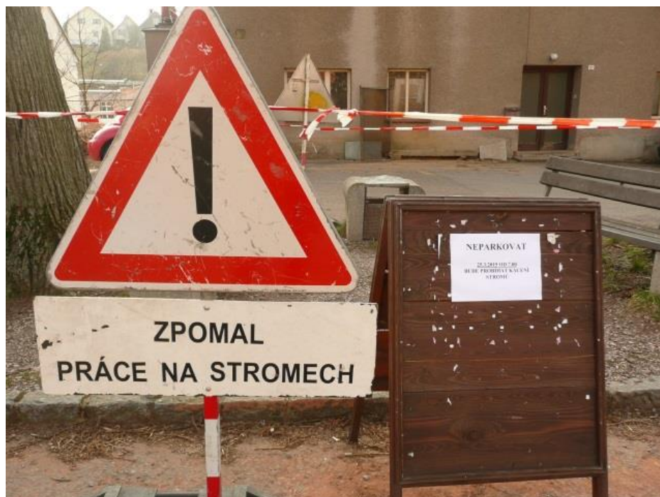
Obr. 2: ohraničení pracovní plochy, kde bude probíhat kácení, může být doplněno i výstražnými značkami s doplňkovou informační cedulkou
