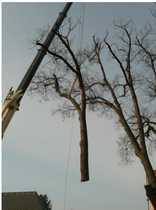
Obr. 53: odříznutá část stromu spouštěná jeřábem na zem
