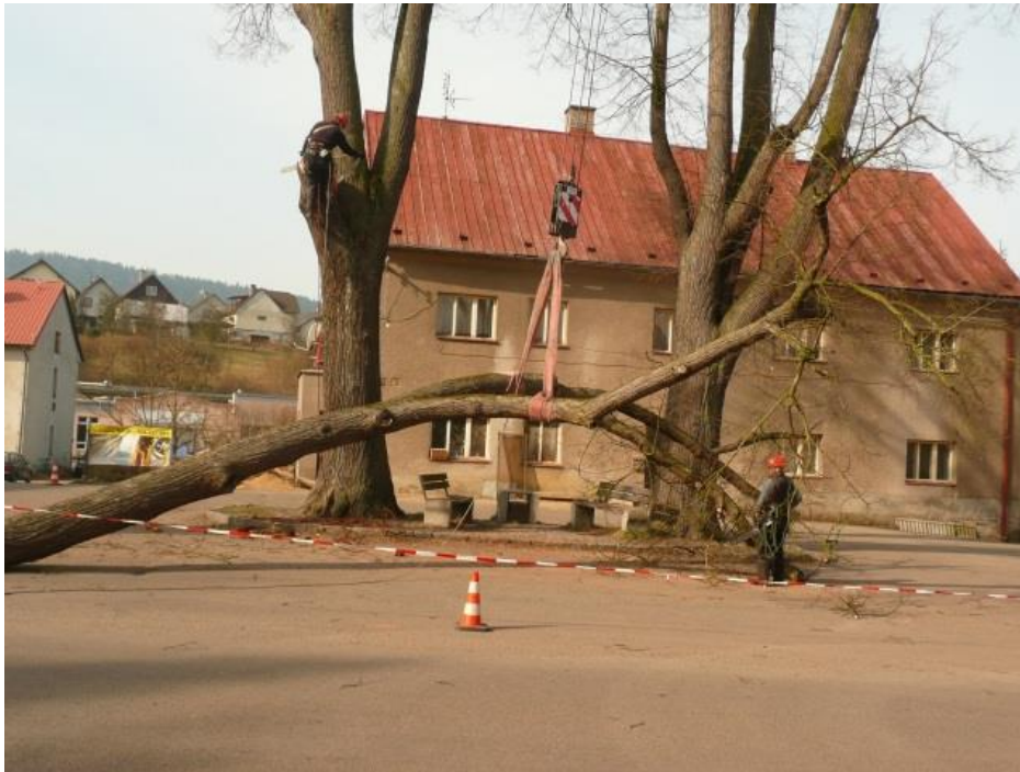
Obr. 1: nebezpečný prostor, v kterém je prováděno kácení, ohraničen páskou a kužely, aby byl zamezen přístup nepovolaným osobám
