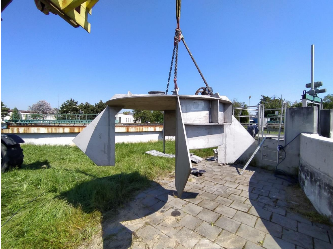
Obr. 36 Tlumící prvek V10 před usazením na RO
