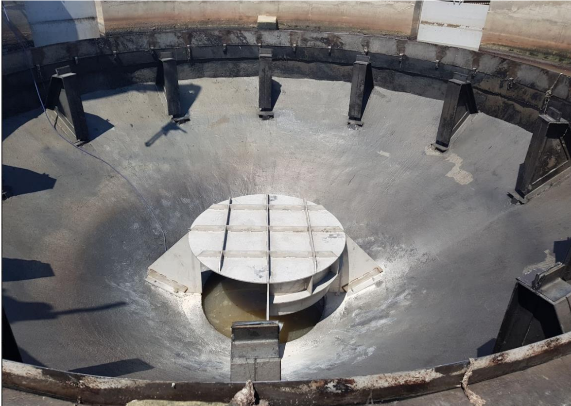
Obr. 38 Usazený tlumící prvek V10 na RO
