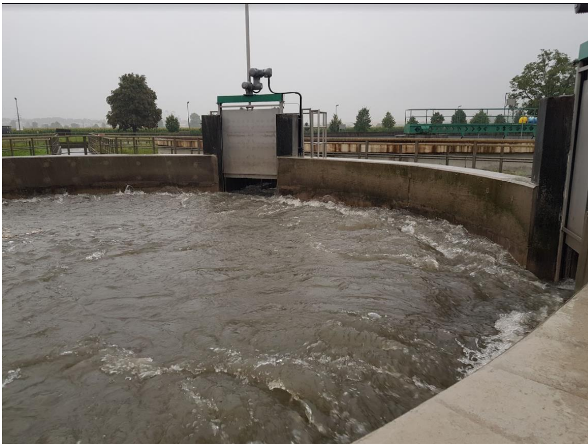
Obr. 39 Proudové poměry upraveného RO při 3,00 \text{ m}^3/\text{s}
