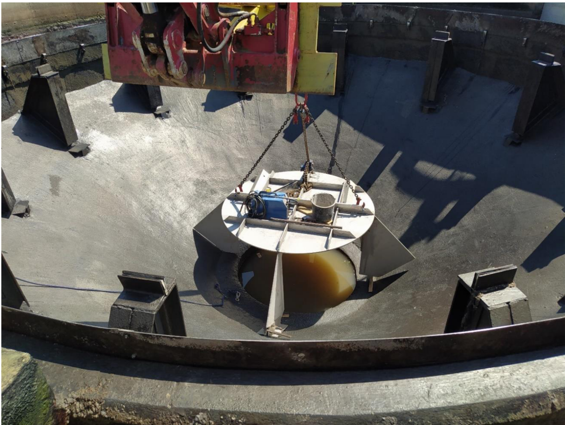
Obr. 37 Usazení tlumícího prvku V10 na RO
