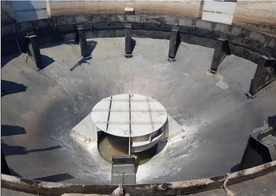
Obr. 38 Usazený tlumící prvek V10 na RO
