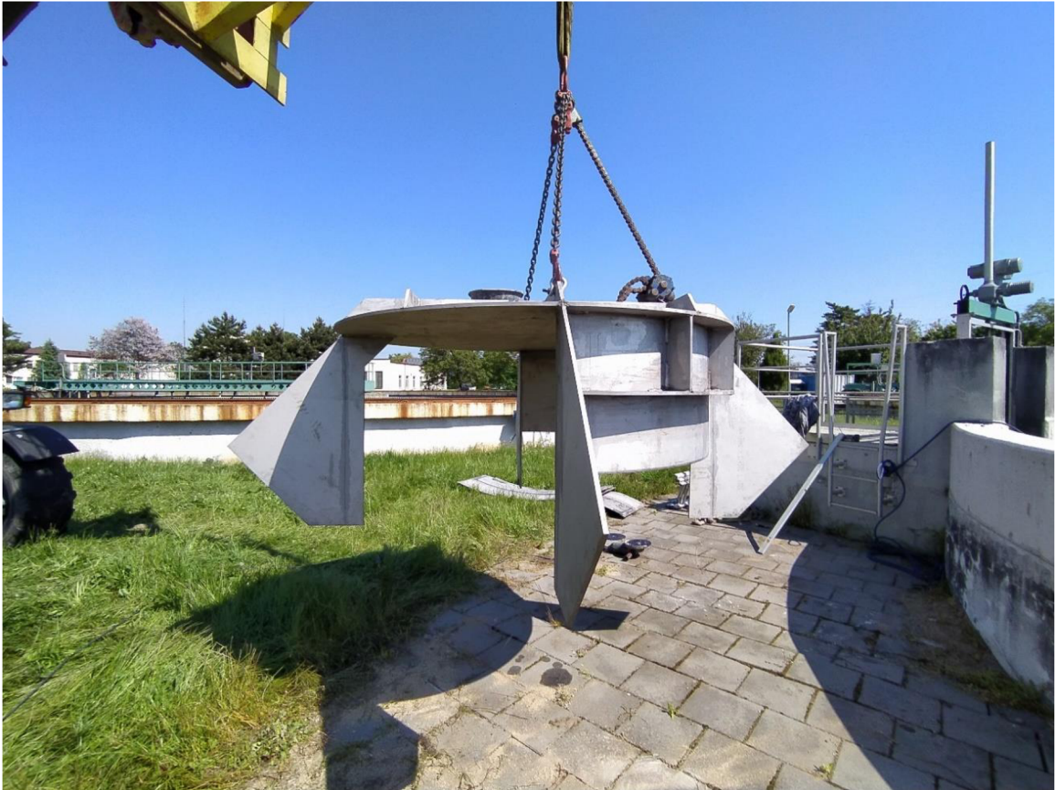
Obr. 36 Tlumící prvek V10 před usazením na RO
