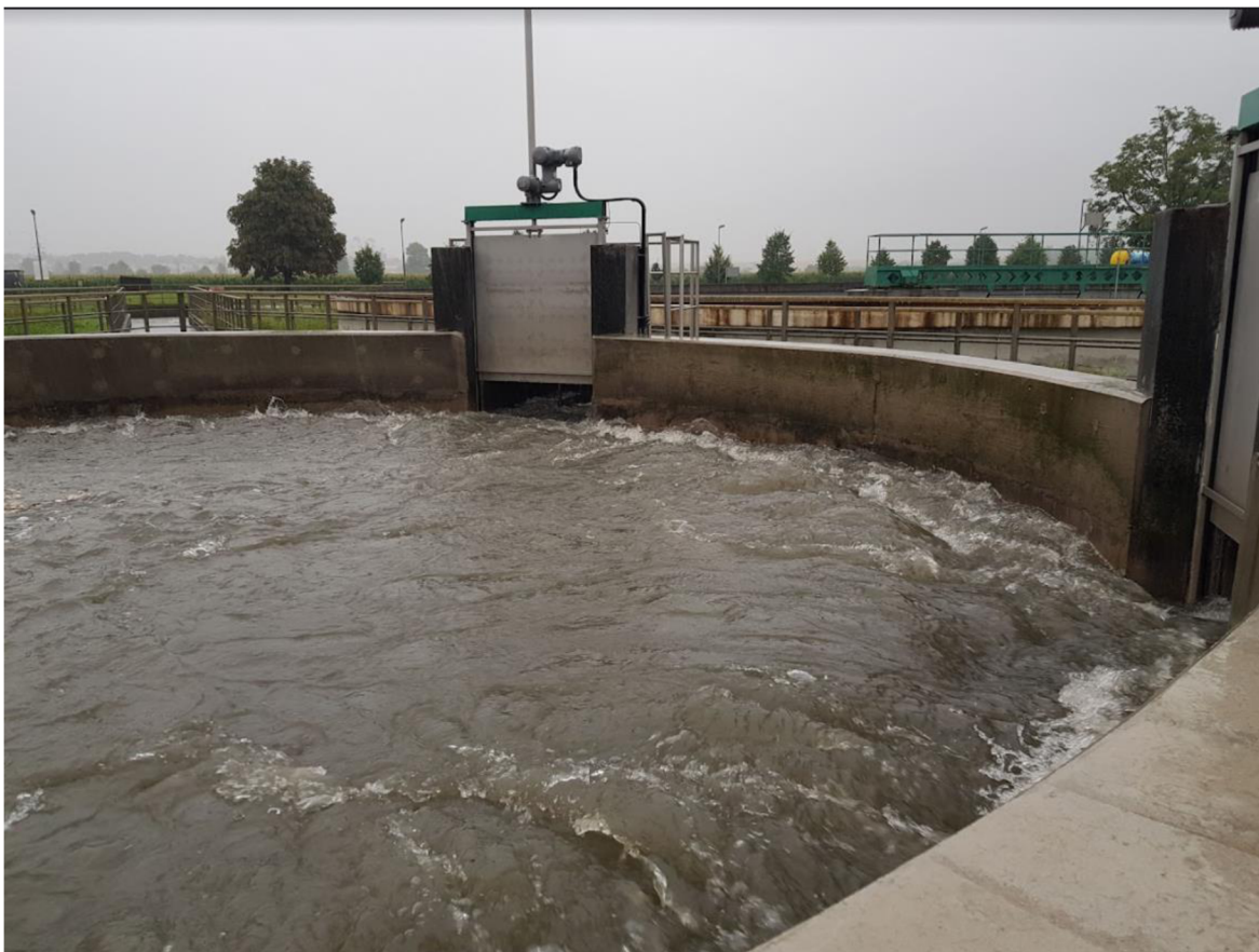
Obr. 39 Proudové poměry upraveného RO při 3,00 \text{ m}^3/\text{s}
