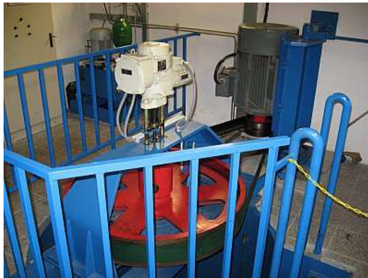
Obr.13 Řemenový převod mezi turbínou a generátorem
