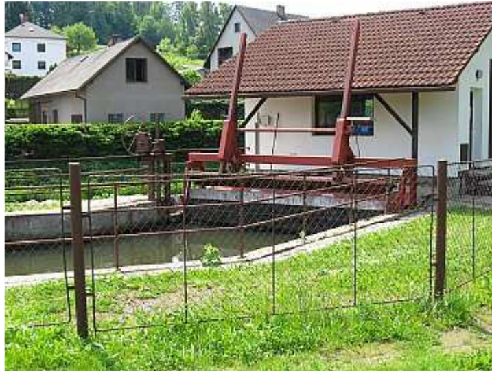
Obr.11 Jemné česle s hrabacím soustrojím
