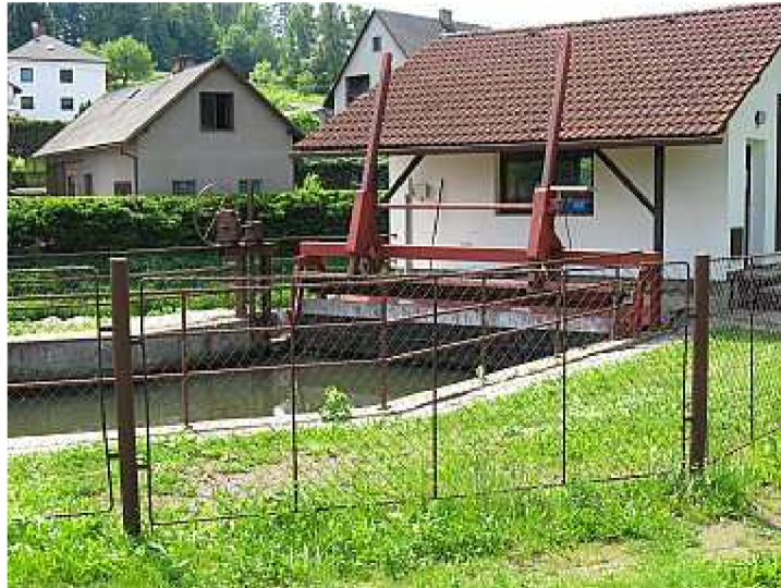
Obr.11 Jemné česle s hrabacím soustrojím
