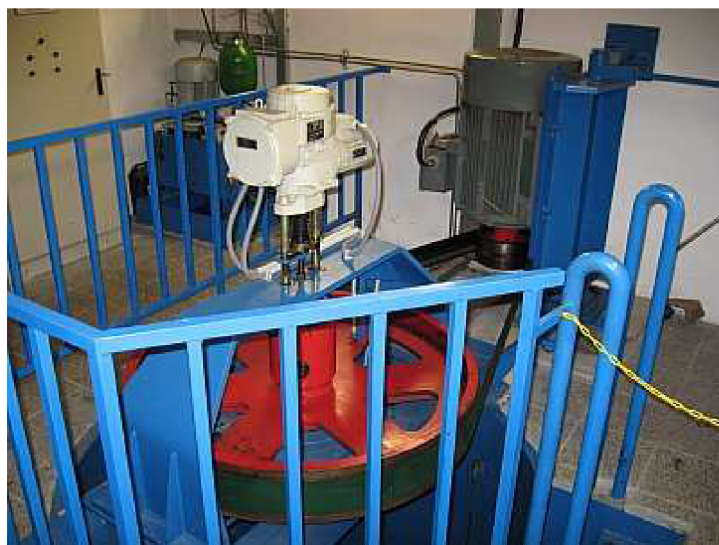
Obr.13 Řemenový převod mezi turbínou a generátorem
