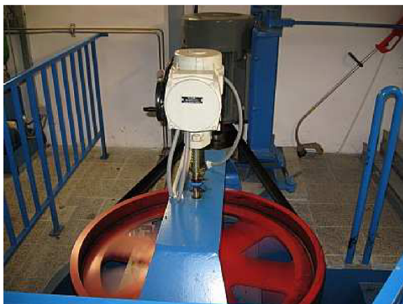
Obr.16 Elektrický servomotor, který ovládá natočení oběžných lopat
