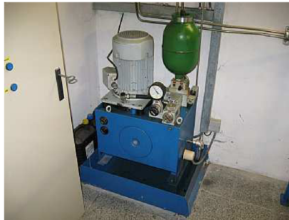
Obr.15 Hydraulický agregát
