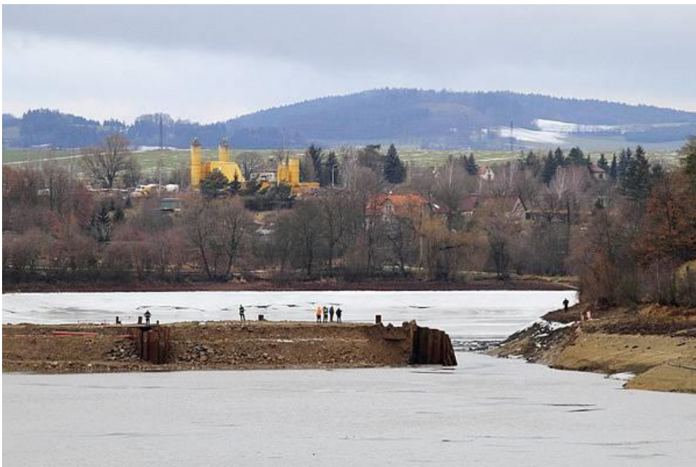
Příloha č. 11. Protržení provizorní hráze při odbahňování Jordánu
