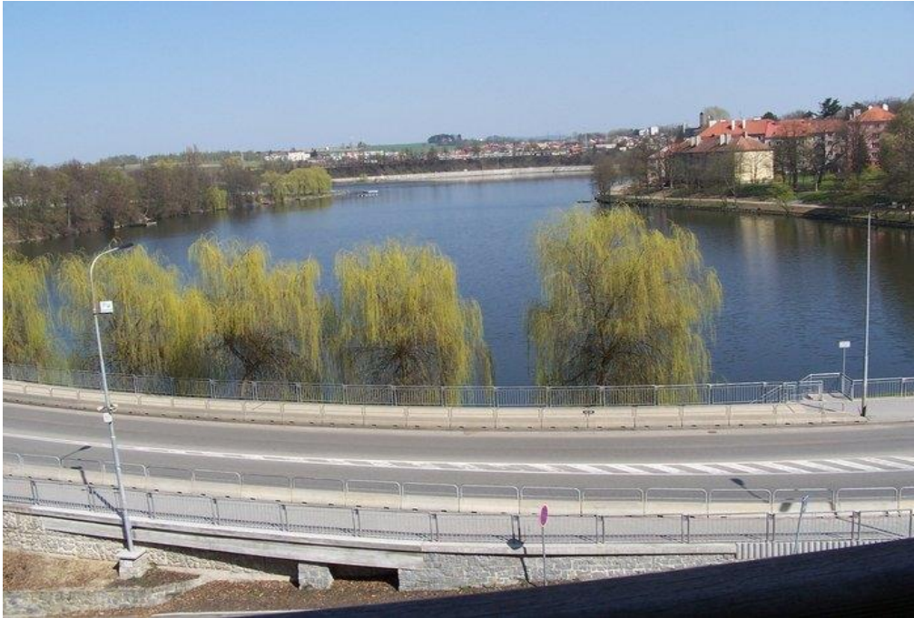
Příloha č. 10. Fotografie údolní nádrže Jordán
