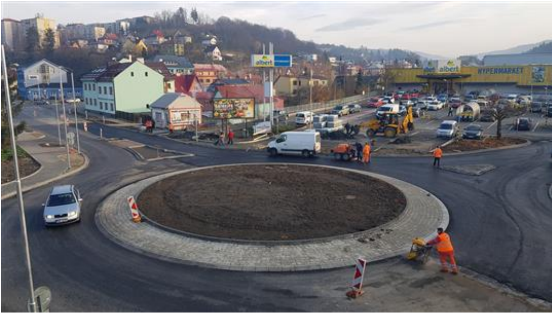
Obr. 20 Výstavba okružní křižovatky na podzim roku 2019 [Zdroj: [21]]
