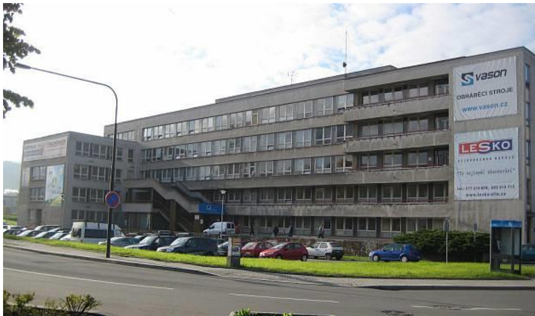
Obr. 8 Poliklinika před rekonstrukcí [Zdroj: [21]]
