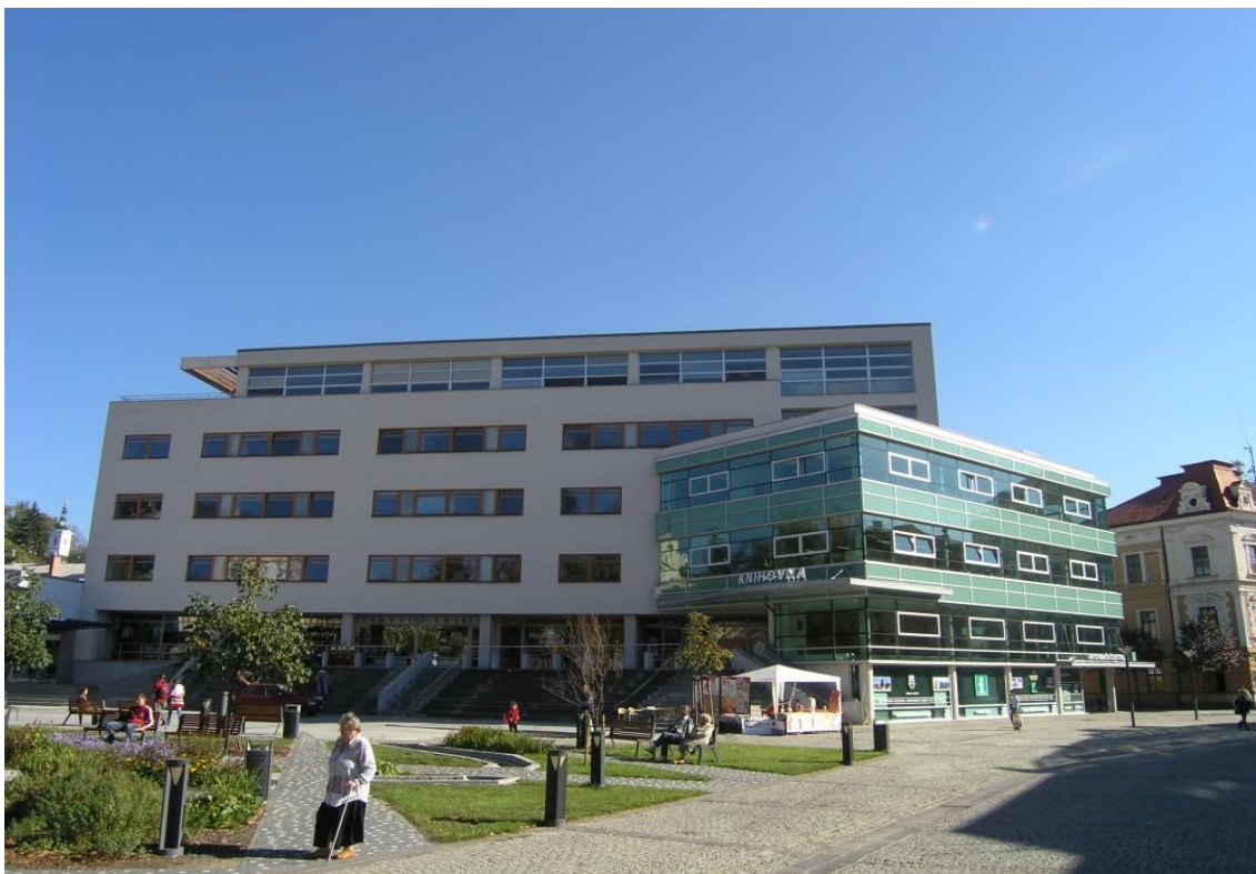
Obr. 12 Dolní náměstí – pohled na budovu „Kremlu“ a městské knihovny [Zdroj: [21]]
