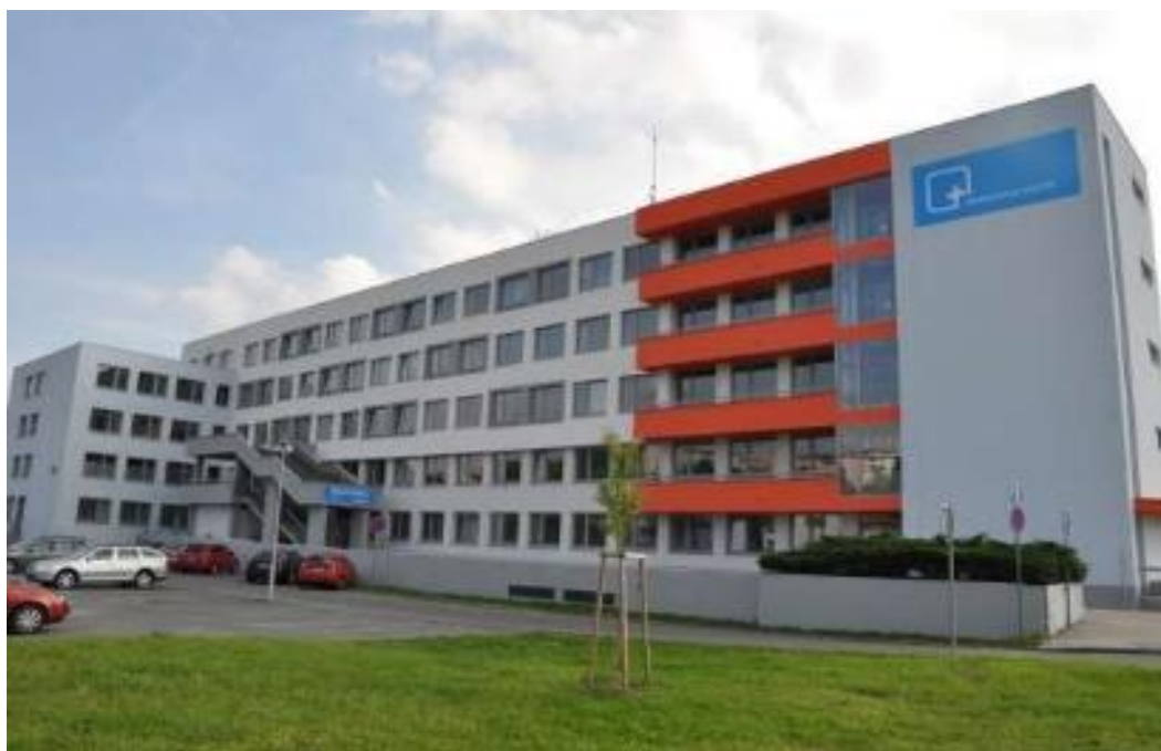
Obr. 9 Poliklinika po rekonstrukci v roce 2014 [Zdroj: [21]]
