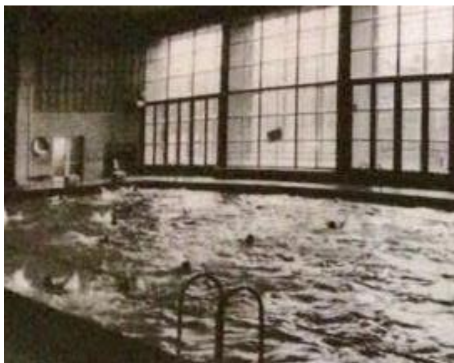
84. Pohled na interiér prostějovských lázní, 60. léta 20. století
