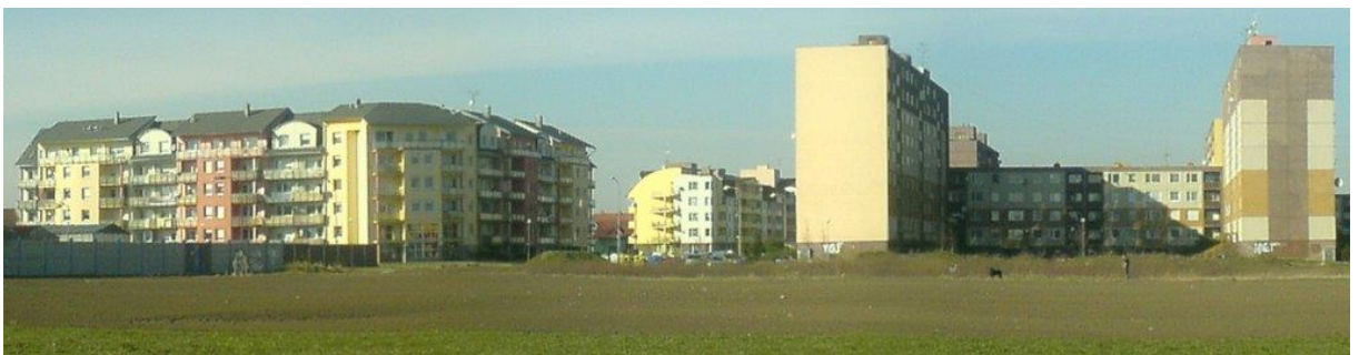
50. Sídlíště Prostějov-západ v Prostějově, 1997
