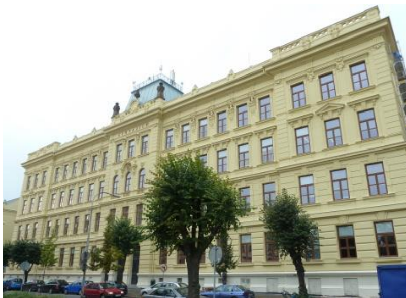
31. Pohled na Gymnázium Jiřího Wolкера v Prostějově, současný stav
