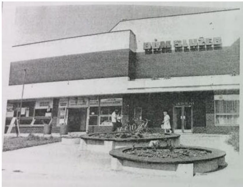
69. Dům služeb na Olomoucké ulici v Prostějově, 1984
