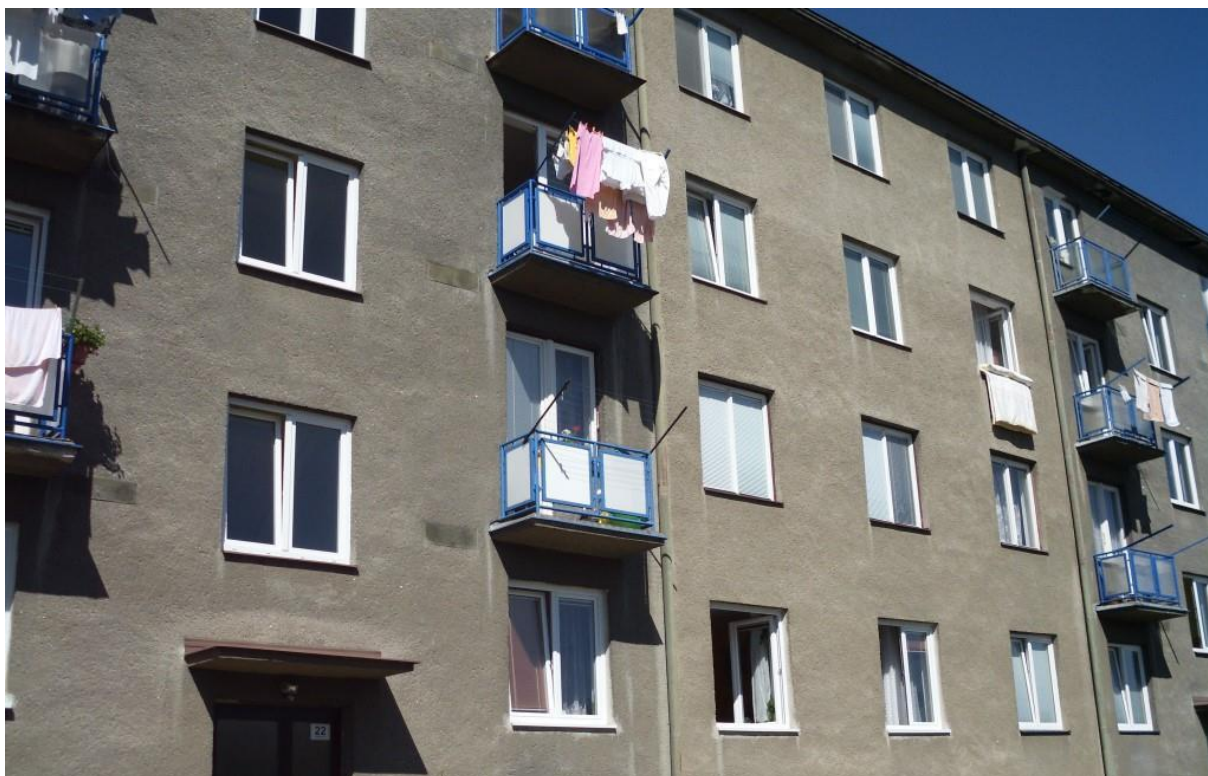
29. Pohled na Krapkovu ulici v Prostějově, současný stav
