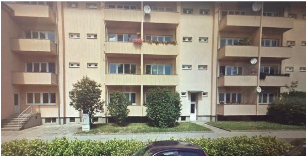
28. Pohled na Dykovu ulici v Prostějově, současný stav
