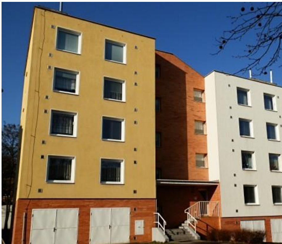
58. Brněnská ulice v Prostějově, současný stav
