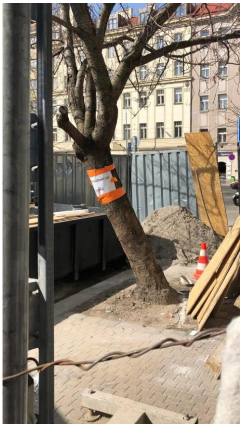
Obr. č. 12 strom na staveništi (autorka 2022)
