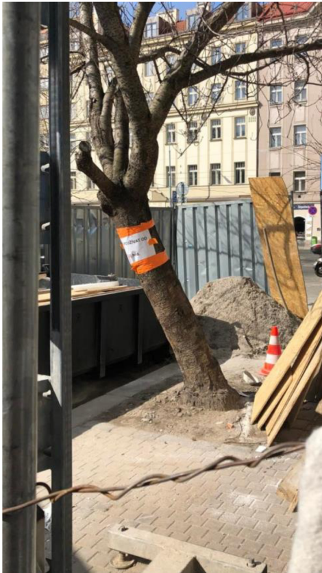
Obr. č. 12 strom na staveništi (autorka 2022)
