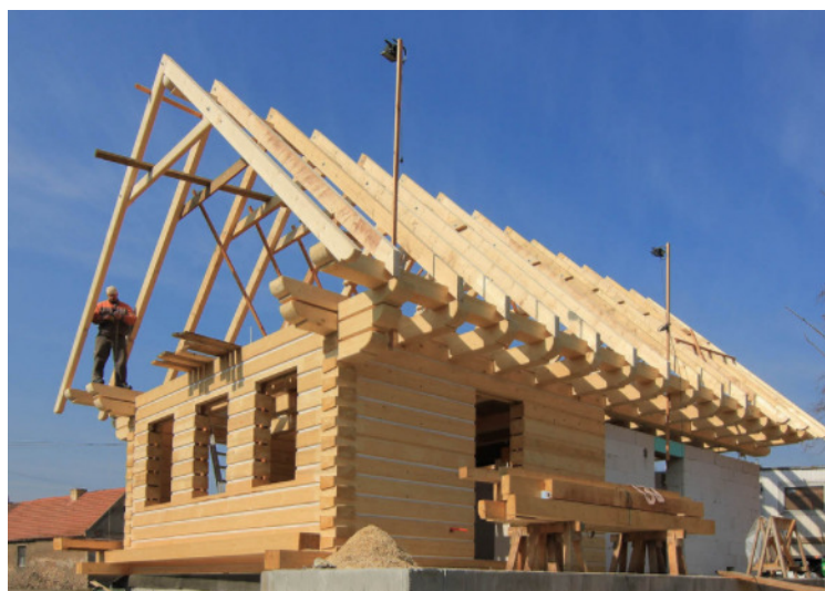
Obr. 21: Výstavba roubenky na stavebním pozemku (Haniš, 2018)
