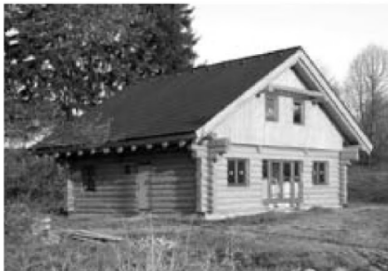
Obr. 5: Roubená konstrukce (Pešta, 2013)
