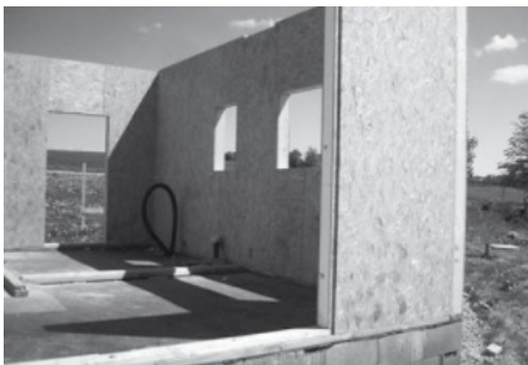
Obr. 13: Výstavba rodinného domu z prefabrikovaných panelů (Hájek a kol. 2014)
