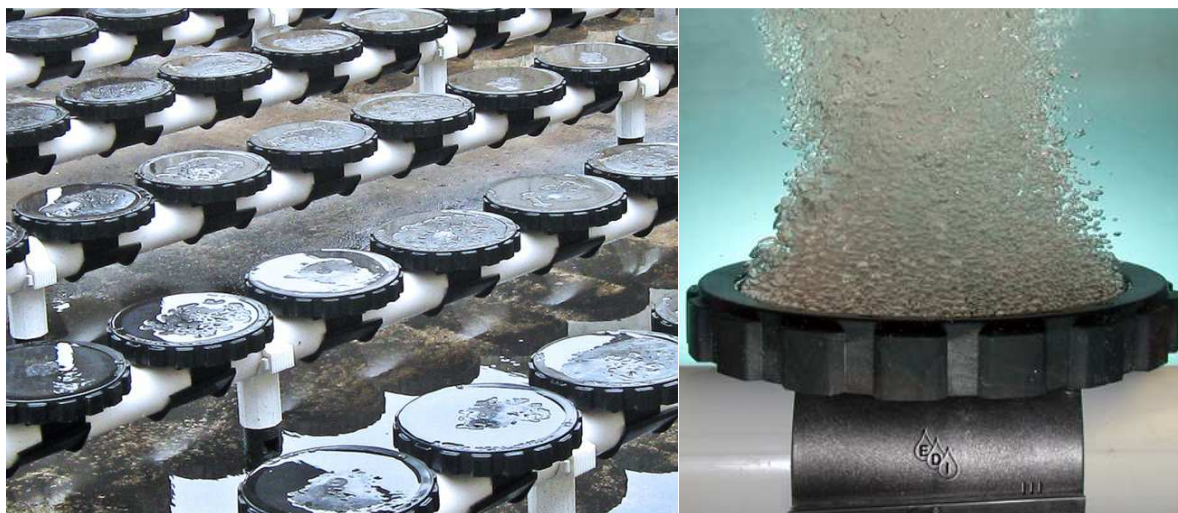
Obrázek 3.5-7 Jemnobublinný diskový aerační systém ATAir [15]
