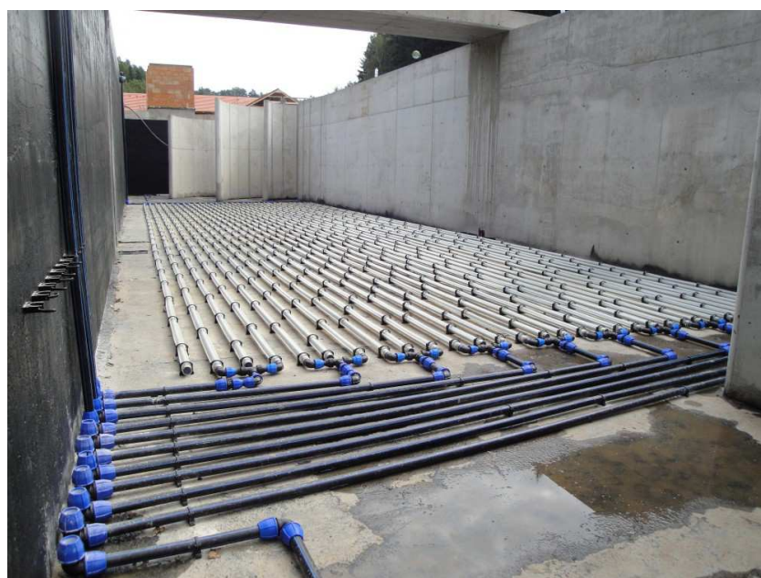
Obrázek 3.5-1 Aerační systém firmy Kubíček (kruhová nádrž) [18]
