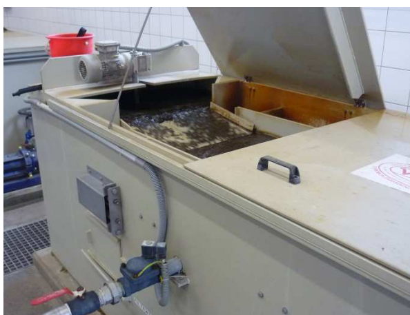
Obrázek 4.3-11 Strojní zahuštění kalu
