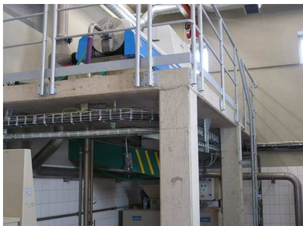
Obrázek 4.3-11 Strojní zahuštění kalu
