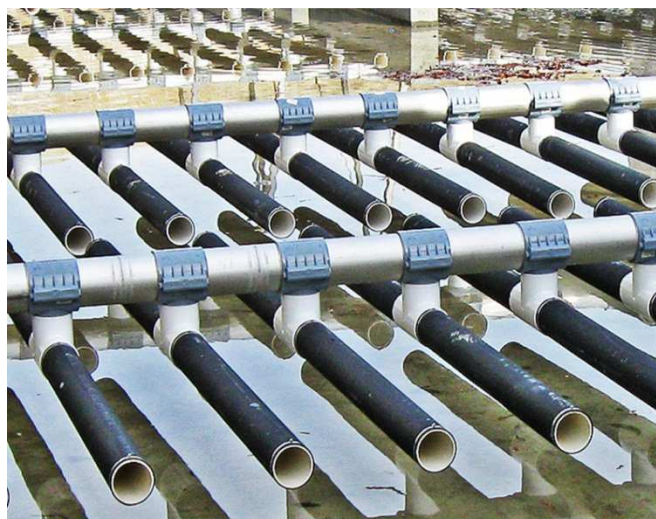
Obrázek 3.5-8 Jemnobublinný trubkový aerační systém ATAir [15]
