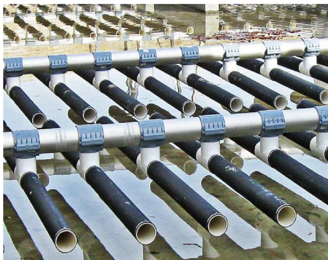
Obrázek 3.5-8 Jemnobublinný trubkový aerační systém ATAir [15]
