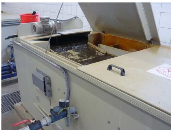
Obrázek 4.3-11 Strojní zahuštění kalu
