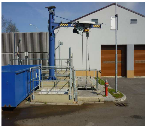
Obrázek 4.3-1 Jímka pro fekální vozy
