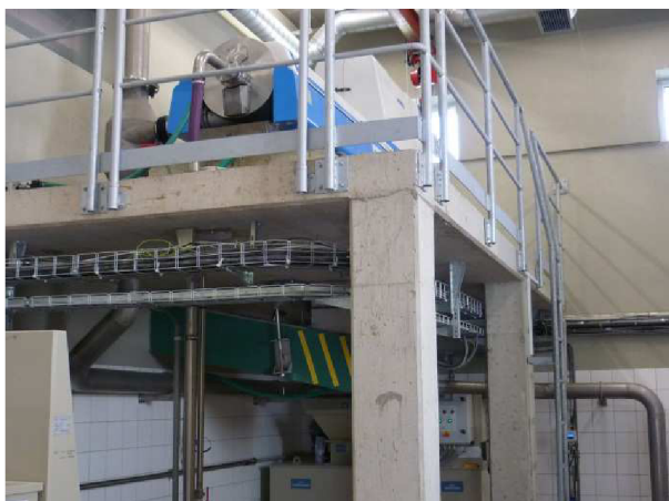
Obrázek 4.3-11 Strojní zahuštění kalu
