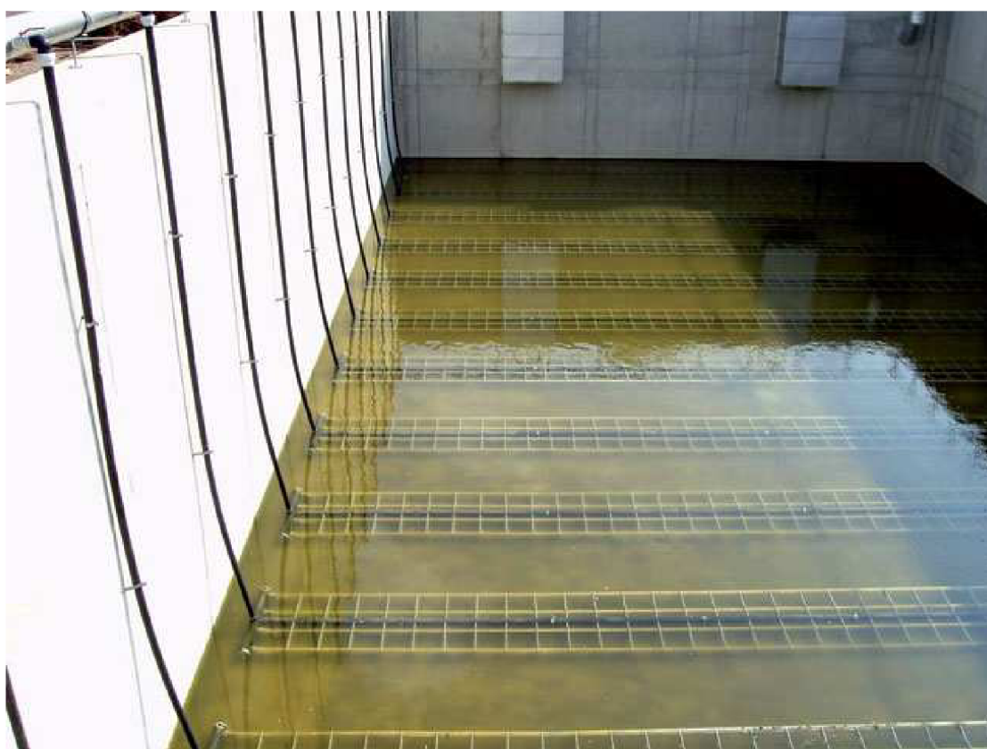
Obrázek 3.1-1 Roštový systém jemnobublinné aerace na ČOV [8]
