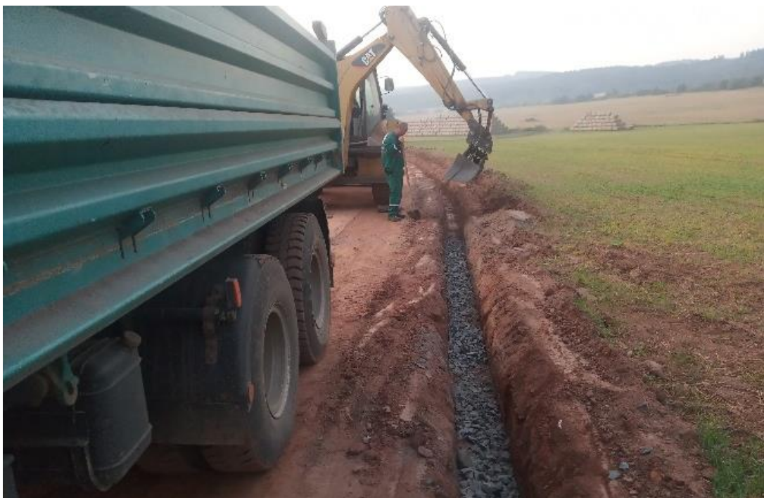
Obrázek 26: Realizace polní cesty VPC 8, pokládání drenáže, rok realizace 2020 (NOVOTNÁ 2020)
