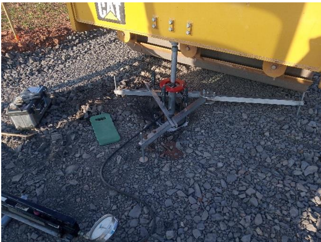
Obrázek 27: Realizace polní cesty VPC 8, hutnicí zkoušky na zemní pláni, rok realizace 2020 (NOVOTNÁ 2020)
