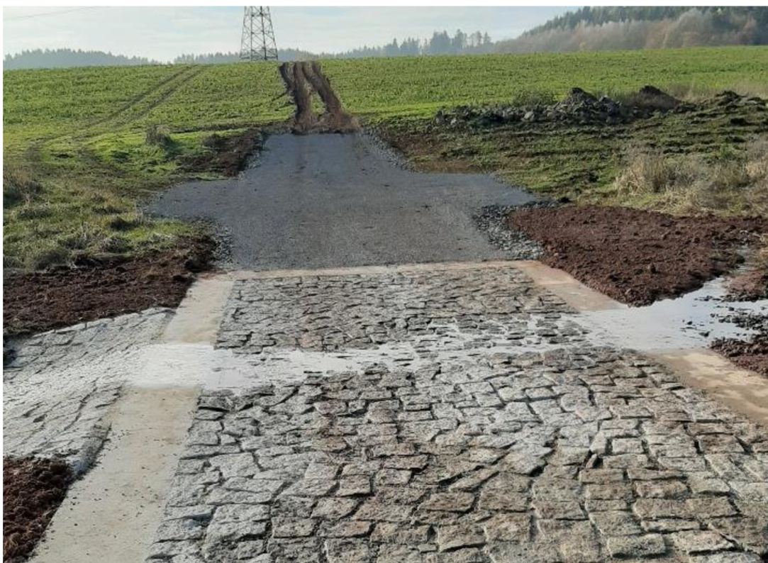
Obrázek 23: Polní cesta VPC 13, niveleta v místě brodu – úprava PD, rok realizace 2020 (NOVOTNÁ 2020)
