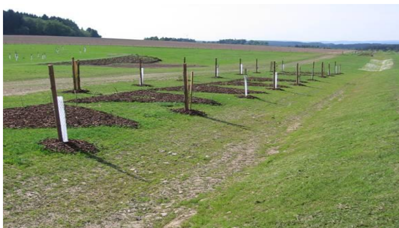
Obrázek č. 5: Zasakovací příkop
