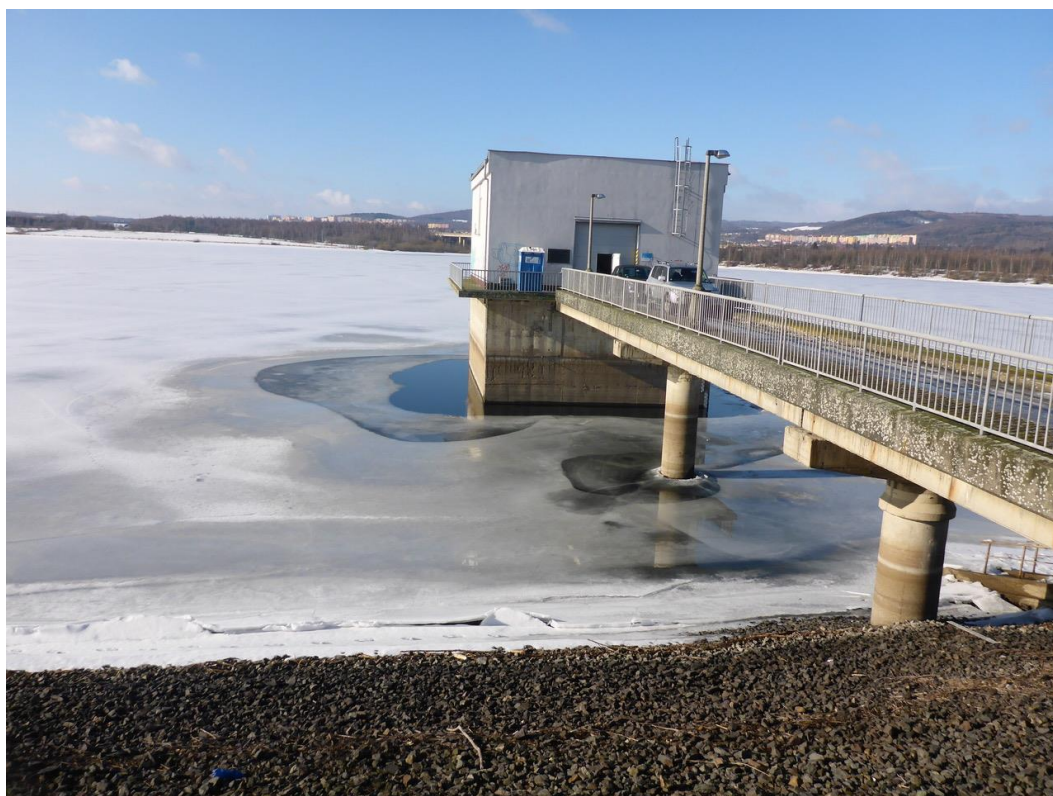
Obrázek 29 Rozmrzlá hladina okolo věžového objektu bublinkovým rozmrazovačem (archiv povodí Ohře, 2018)
