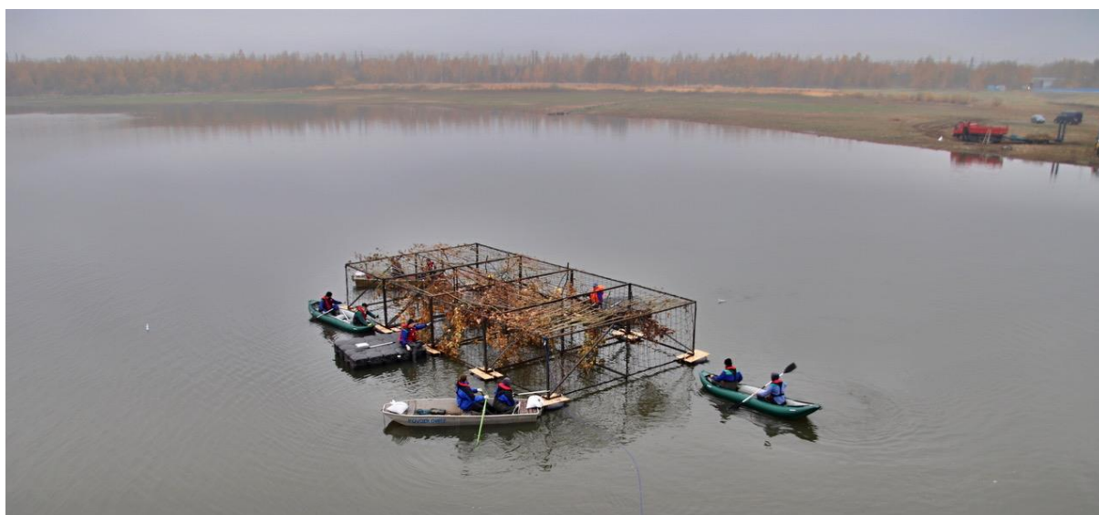
Obrázek 25 Instalace umělého rybiho úkrytu (Archiv povodí Ohře, 2018)
