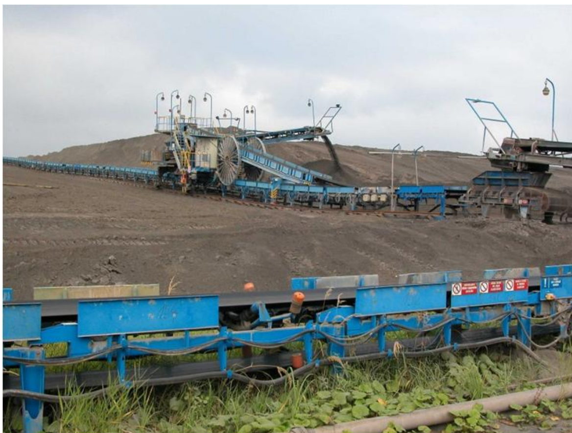
Obrázek 11: Zauhlování tepelné elektrárny (Zdroj: [20], původně převzato z prezentace společnosti NOEN)
