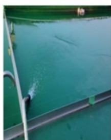
Modrá střecha: využití hrzení pro zadržování srážkové vody
