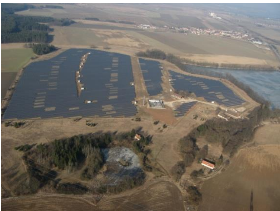
Obr. 14 Západní blok FV elektrárny Ševětín s el. rozvodnou, autor David Sochr, 5. 3. 2011
