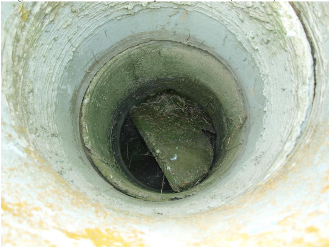
Fotografie č. 18 – pohled do osmé šachtice (Polešovice)
