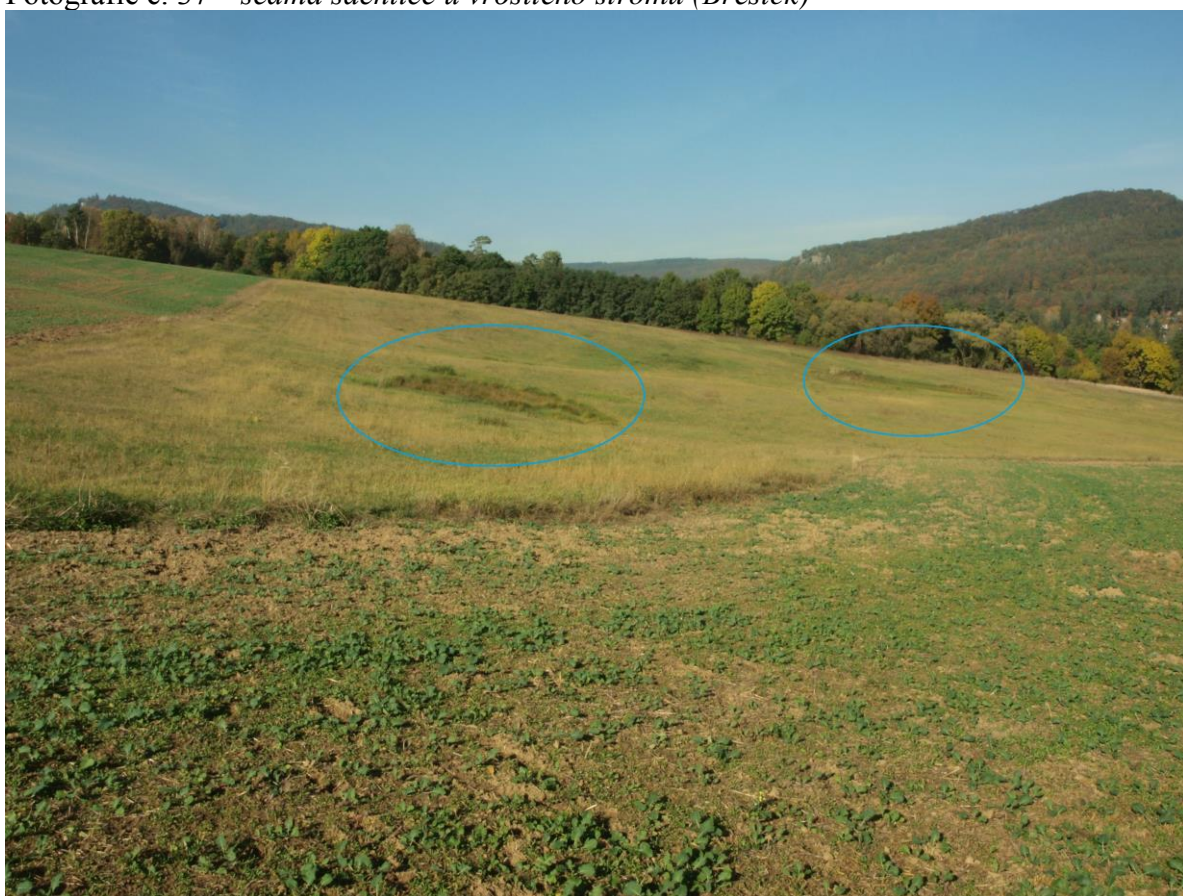
Fotografie č. 38 – zaznačená místa s vyvěrající vodou (Břestek)
