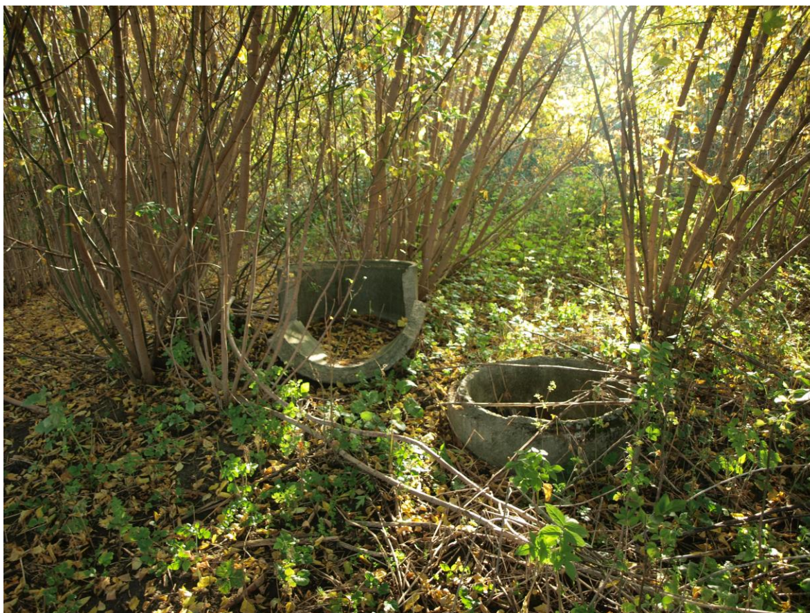
Fotografie č. 3 – zničená betonová skruž vedle šachtice (Polešovice)
