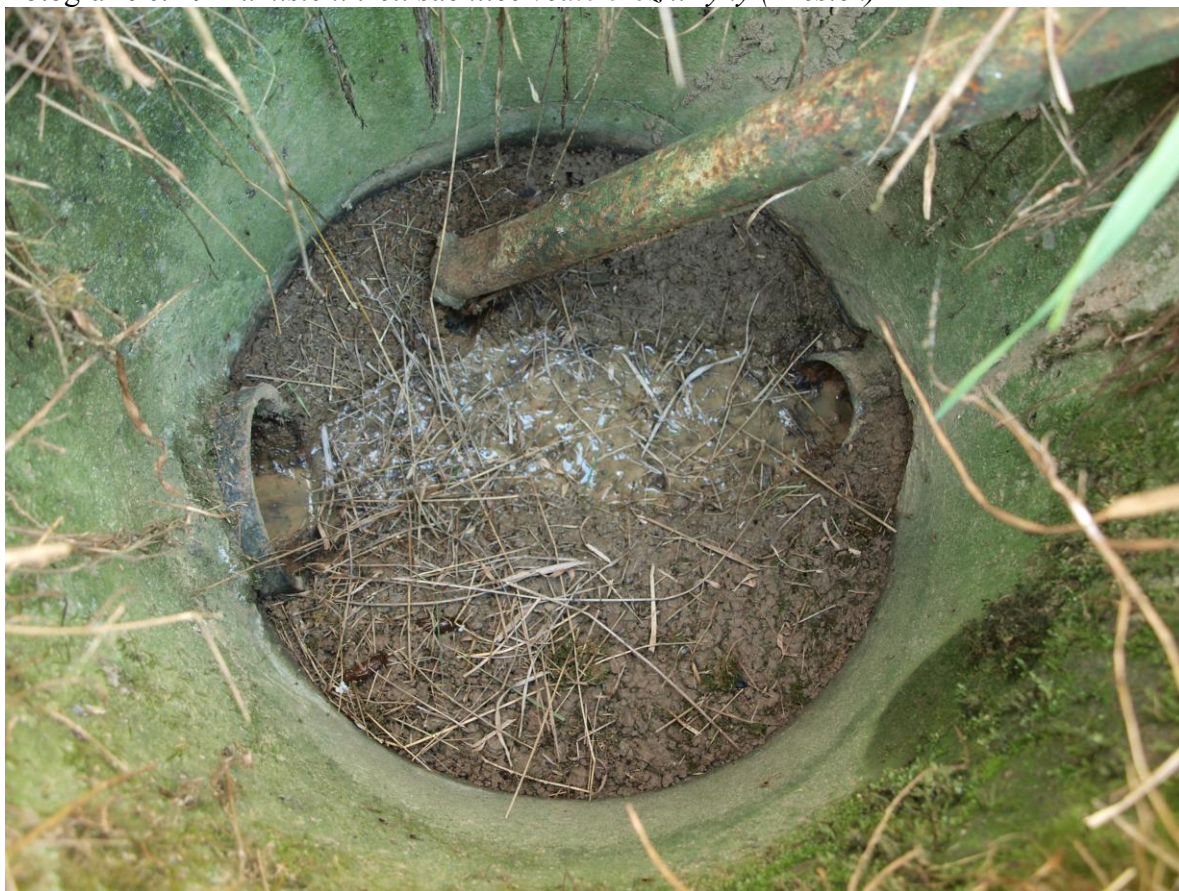
Fotografie č. 30 – pohled do třetí funkční šachtice (Břestek)
