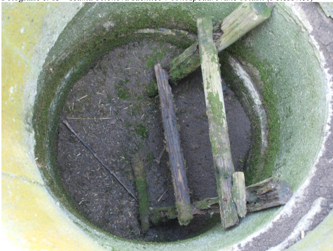
Fotografie č. 16 – pohled do betonové šachtice (Polešovice)
