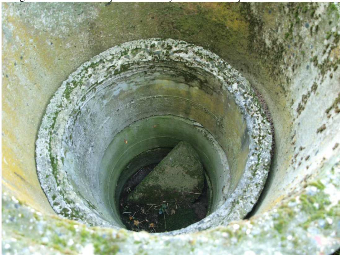
Fotografie č. 12 – pohled do páté šachtice (Polešovice)
