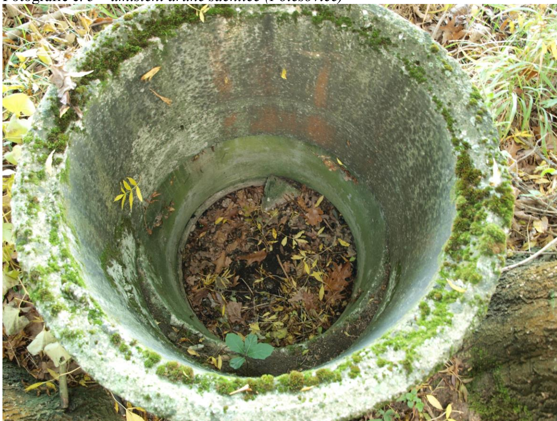
Fotografie č. 6 – pohled do druhé šachtice (Polešovice)
