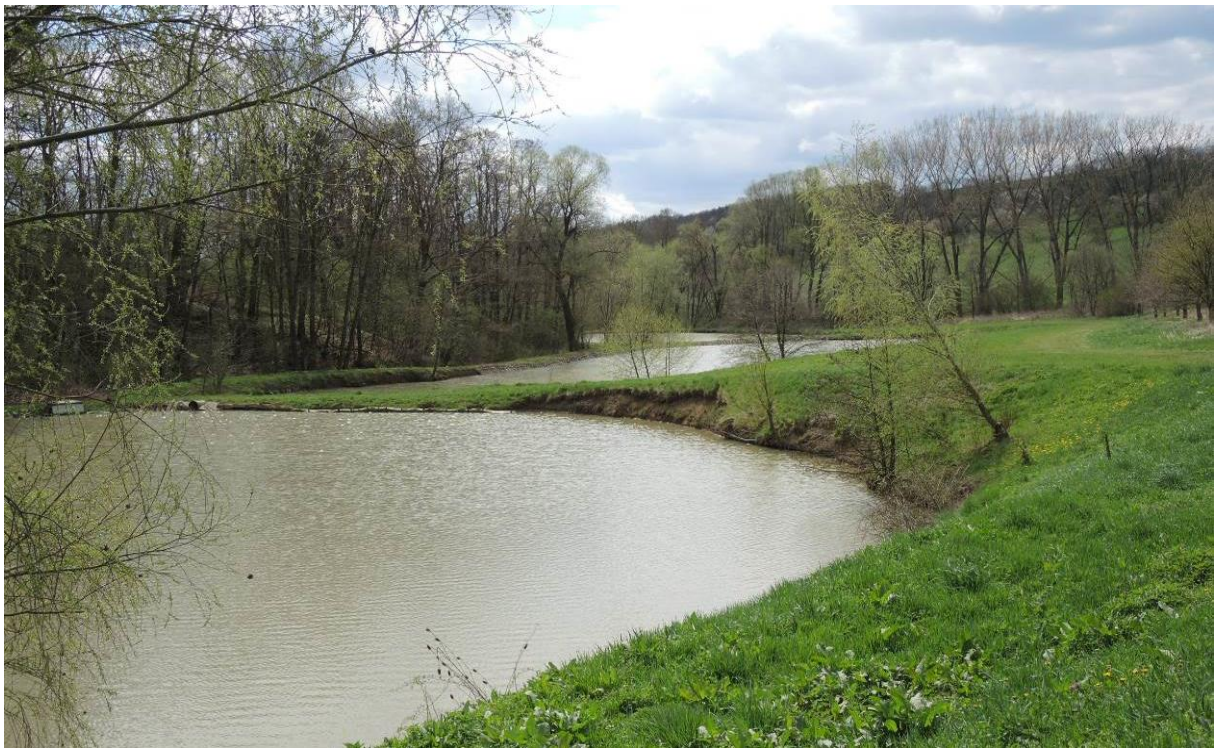
Obr. 18 Mistřické rybníky 0,4 km JV od Javorovce (2015)
