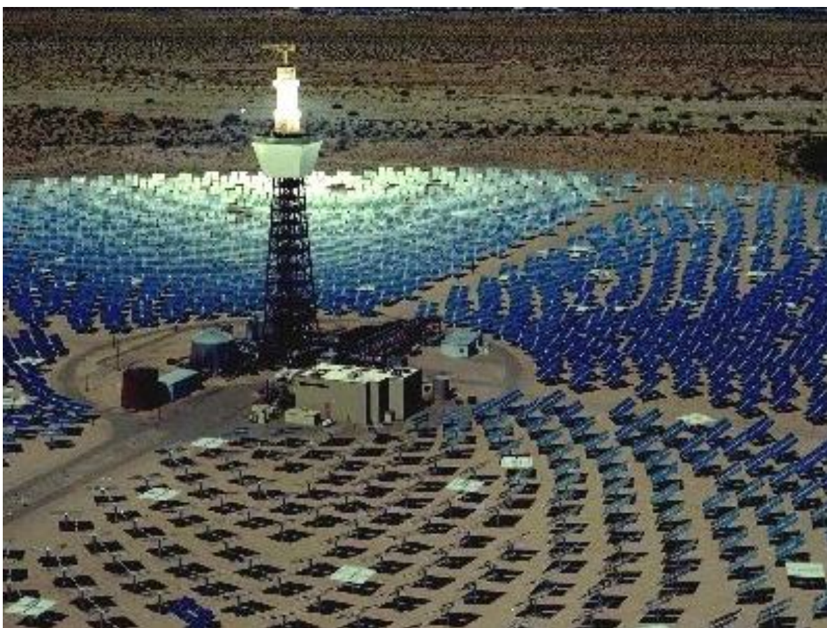
Obr. 15: Věžová elektrárna s heliostaty – Solar Two. [14]
