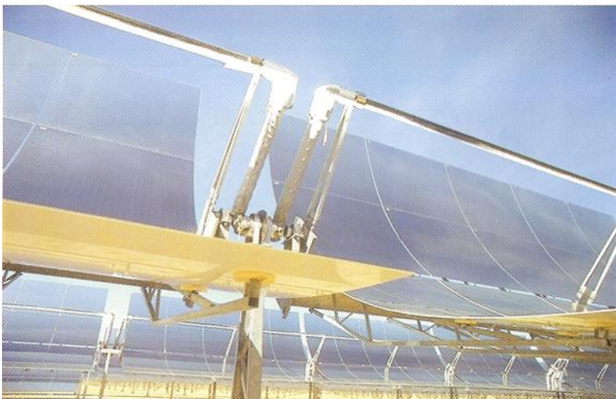
Obr. 12: Žlabový parabolický koncentrátor s maximálním výkonem P_{\max} = 354 \text{ MW}_p [4]
