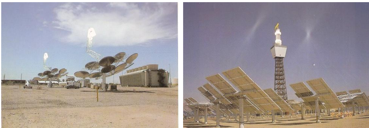
Obr. 14: Systémy koncentrátorů slunečního záření, vlevo se nachází parabolický koncentrátor s bodovým ohniskem, vpravo se nachází věžová elektrárna s rovinnými zrcadly. [4]
