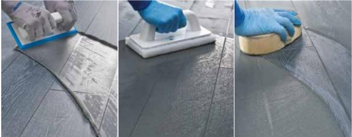
Obrázok č.1: Nanášanie škárovacej hmoty pomocou gumovej stierky [5]
