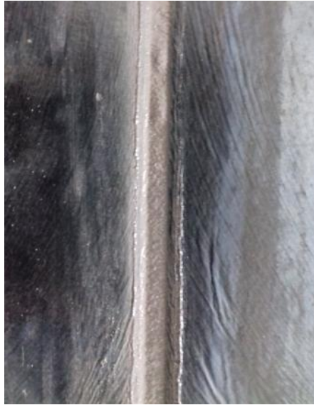
Obrázok č.36: Detail zaškárovanej dlaždice vytvorenou škárovacou hmotou
