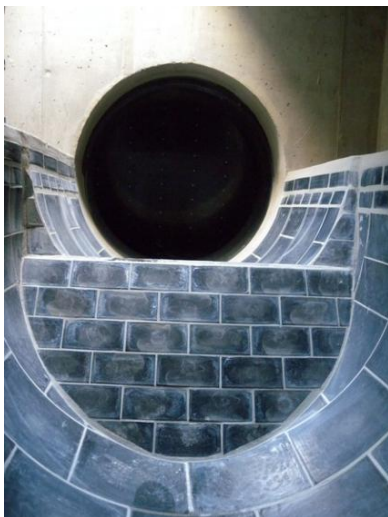
Obrázok č.8: Obloženie prepadovej hrany výrobkami z taveného čadiča v kanalizačnej stoke [15]
