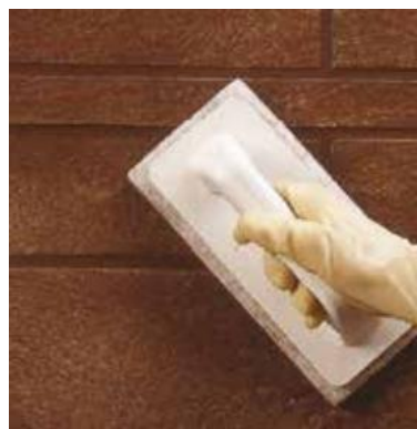
Obrázok č.5: Čistenie škár po čiastočnom zatuhnutí [5]
