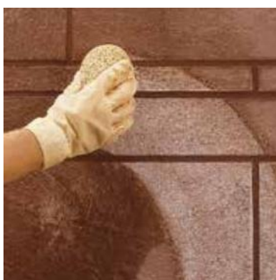
Obrázok č.6: Čistenie a finálne dočistenie škár na stenách s použitím špongie [5]
