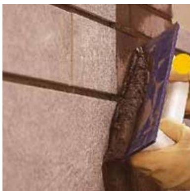
Obrázok č.4: Nanášanie škárovacej hmoty na stenu s gumovou stierkou [5]
