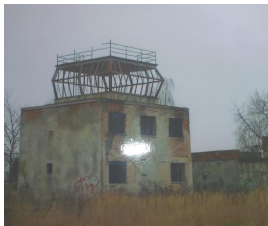
Obr. č. 6.: Řídicí věž, stavěná 1948-9, od roku 1991 nepoužívaná
