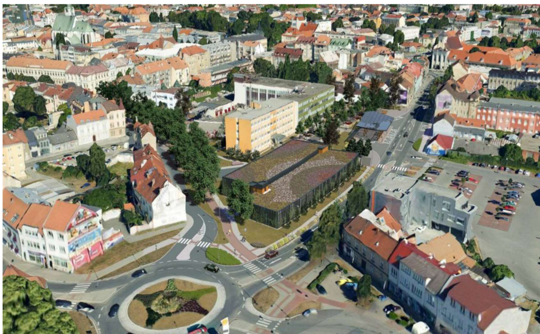
Obr. 2.8 Parkovací dům ul. Újezd
