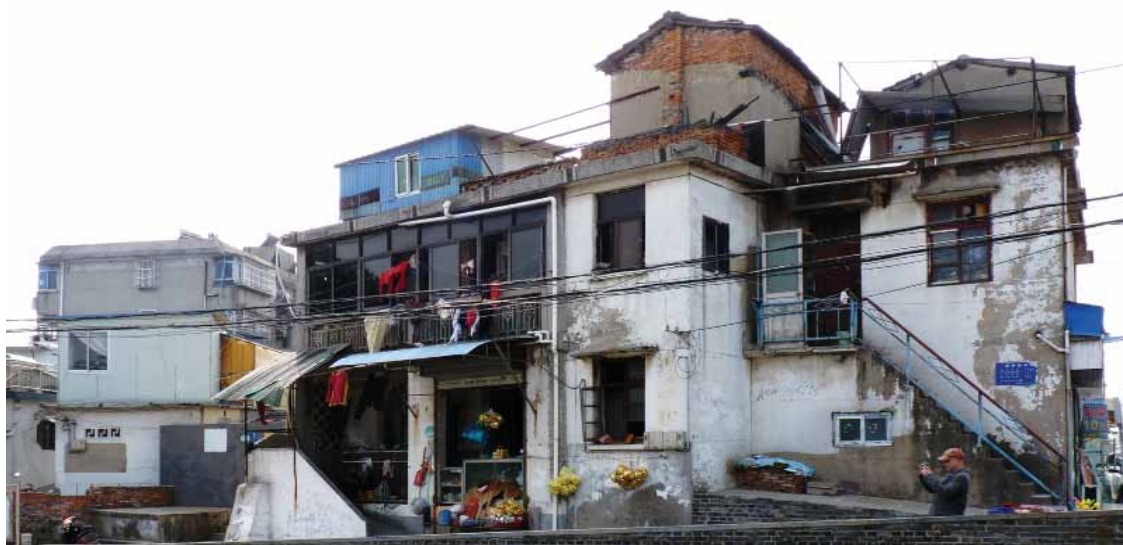
Obr. 453–455: Friedmanovi architektonické návrhy a rostlý, improvizovaně stavěný dům v Yangzhou v Číně
