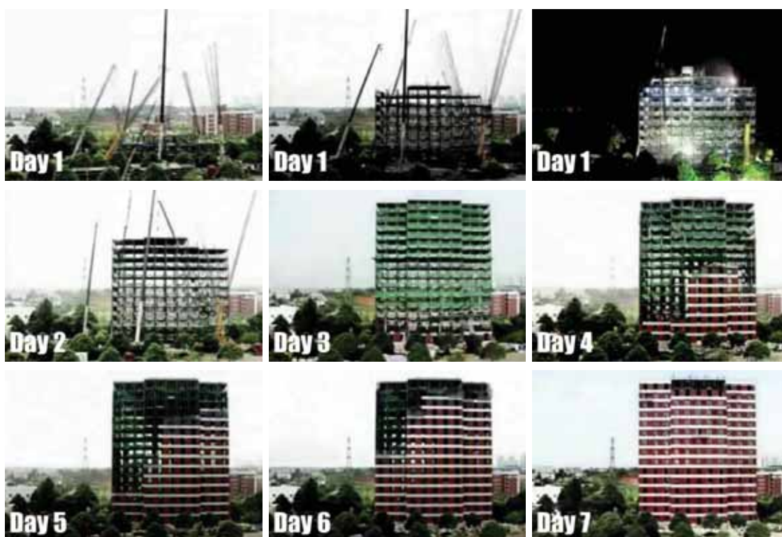
Obr. 362–370: Stavba patnáctipatrového domu za pouhých sedm dní
