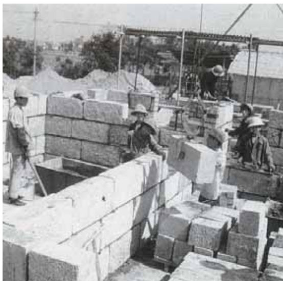
Obr. 231: Stavební systém využívající zdících bloků Zdroj: JUNHUA, Lü; ROWE, Peter G.; JIE Zhang. Modern Urban Housing in China 1840-2000 ; 1. vyd. Prestel Verlag, Munich-London-New York, 2001; ISBN: 3-7913-2507-8; s. 183
