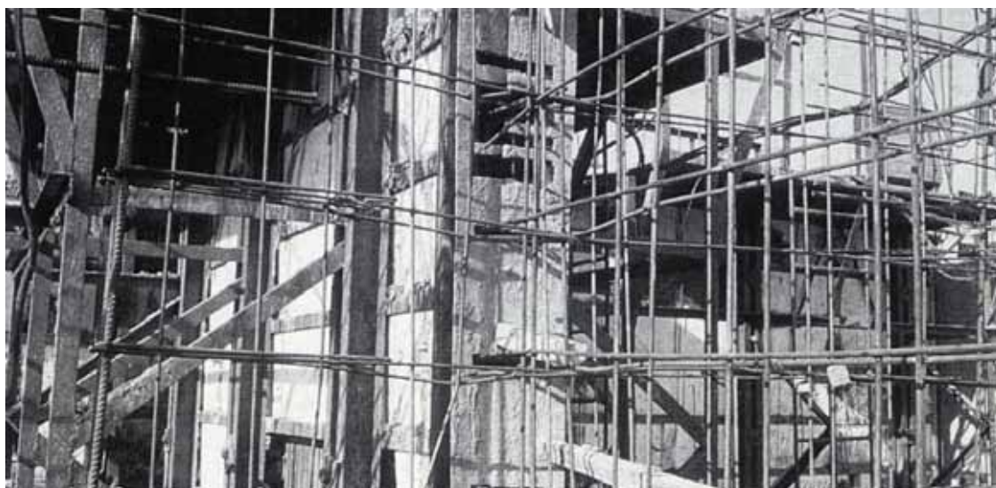
Obr. 230: Konstrukce ze železobetonových panelů odlévaných na místě
