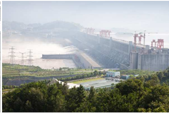
obr. 3 Velká vodní elektrárna
