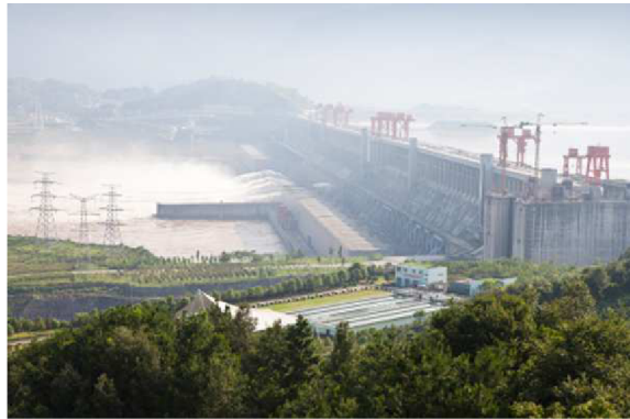
obr. 3 Velká vodní elektrárna
