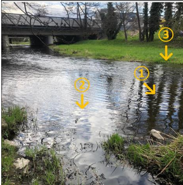
Obrázek 3 Bystřice U Ambulatoria, pohled na železniční most Autor: Hana Dočekalová, 2023
