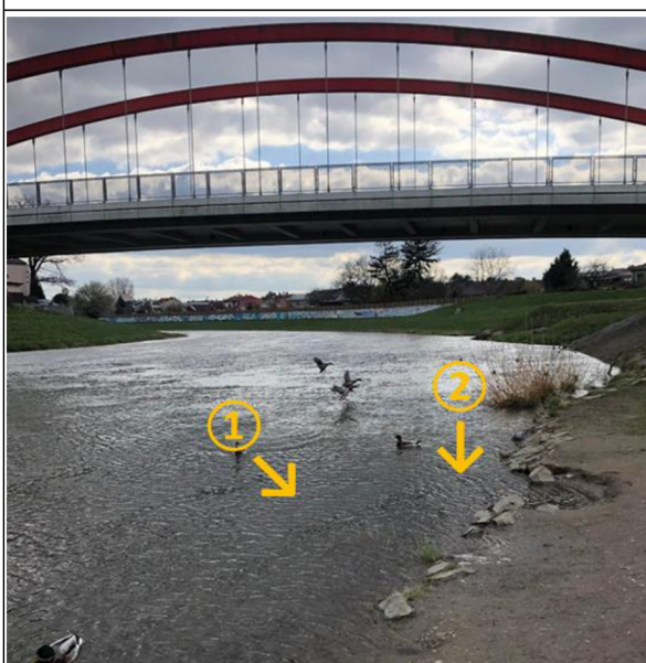
Obrázek 1 Morava – U Dětského domova, pohled na silniční most Autor: Hana Dočekalová, 2023
