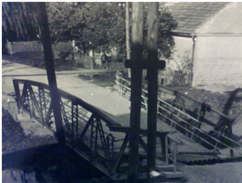
Fotografie č. 1: Zřícený most ve Štěpánově na konci druhé světové války. Květen 1945. 279
