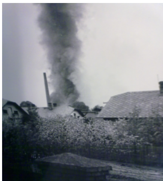
Fotografie č. 2: Požár v bývalých štěpánovských železárnách. Květen 1945. 280
