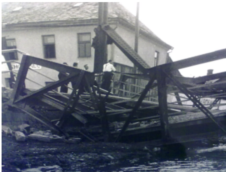
Fotografie č. 3 . Němci vyhození most přes Oskavu. Květen 1945. 281
