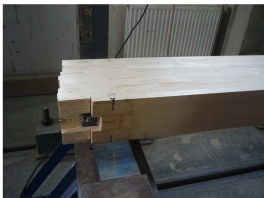
Foto 11 – Usmyknutá výztuž i s dřevěnou lamelou
