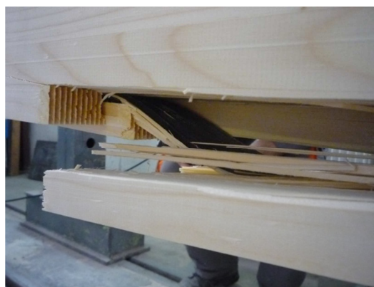
Foto 10 – CFRP lamela v porušeném nosníku
