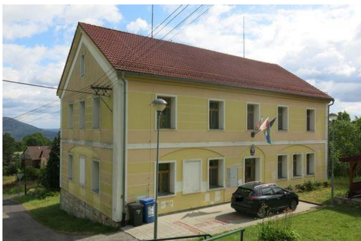
Obrázek 8 Budova ZŠ Huntířov
